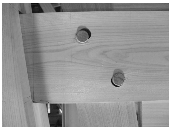
図 5.2.2-6 込栓によるめり込み(横貫) 図 5.2.2-7 たて貫のめり込み(板と貫穴木口による)
