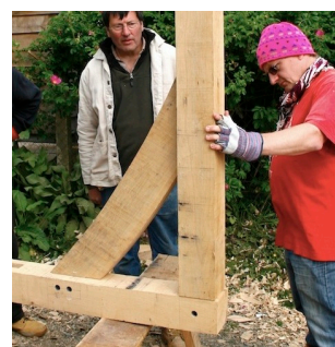
[写真] 柱と梁の仮組み
