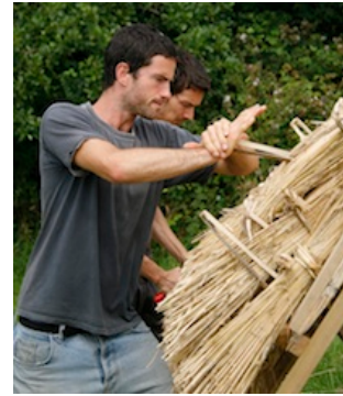
[写真] ハシバミの木で茅を固定する工程を練習する参加者
