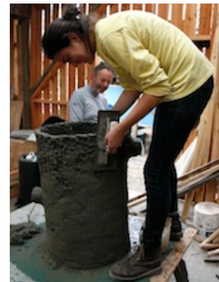
[写真] フェロセメントで汚水浄化槽を作成する参加者
