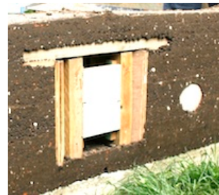
[写真] 窓などの開口部や配管用の穴は、あらかじめ枠を入れておく
