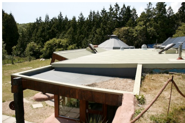
[写真] 屋上では雨水を集めたり、太陽熱温水器や太陽光発電パネルが置かれている
