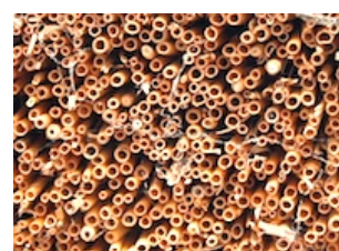
[図] 茅葺き屋根の断面
