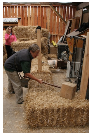
[写真] ストローベイルの組み立て
