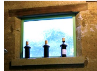
[写真] 窓まわりを室内側より 見る。窓上部には木製の楣 (横 木)，下部にはコンクリート板 が入っている。ラムドアースは 曲げや剪断には弱いため。
