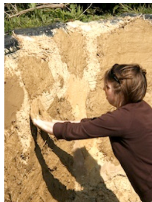
[写真] 積み上げたタイヤの上から土を塗る
