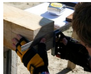
[写真] 柱端部の接合部の加工
