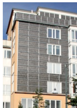
[写真] 高緯度の北欧ならではの壁面に設置された対抗高発電パネル
