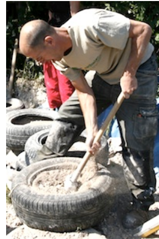
[写真] ハンマーを使って廃タイヤに土を突き込む作業。「タイヤ叩き」と呼ばれる。
