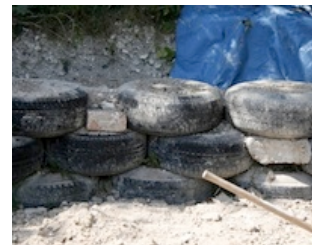
[写真] 土をつめて突き固められ、積み上げられた廃タイヤ
