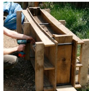
[写真] ラムドアース用の型枠
