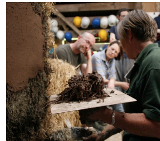
[写真] 壁土を塗る
