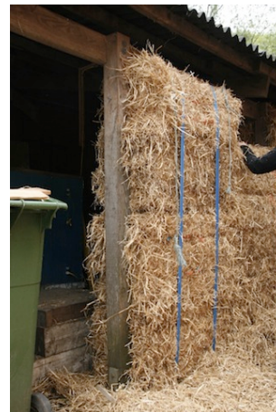
[写真] 木造軸組構法とストローベイルを合わせて使う
