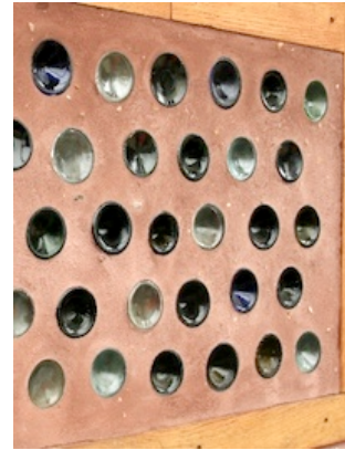
[写真] 空き瓶を利用した明かり取りの窓
