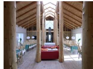
[写真] コモンハウスの内部。 コモンハウスは、製材していない丸太、焼成していない煉瓦、ストローベイルなどを使っている。
