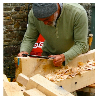
[写真] ブレースの加工
