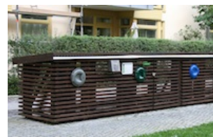
[写真] ゴミ箱に入れたゴミは、順番に処理場まで吸引力で運ばれる
