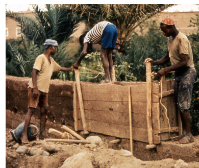
[写真] アフリカでの伝統的な方法 小さな型枠を少しずつ移動する (出典：Maurice Mitchell氏資料)
