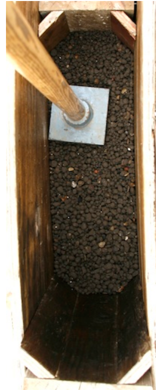
[写真] 型枠の中の土を突き固めているところ
