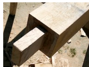
[写真] 柱端部の接合部の加工
