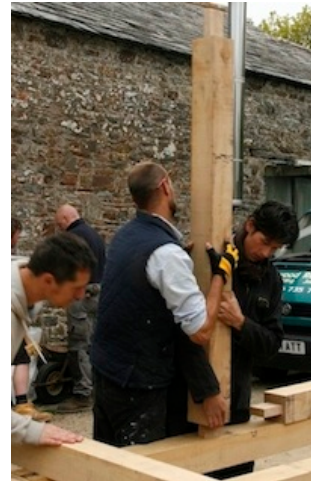
[写真] 柱と土台を組み合わせる
