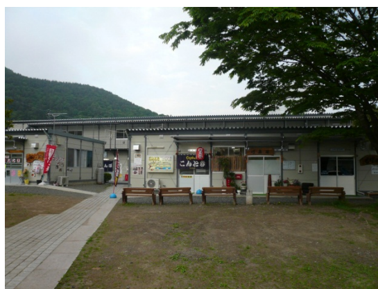
図 3.41 : E棟の外観
