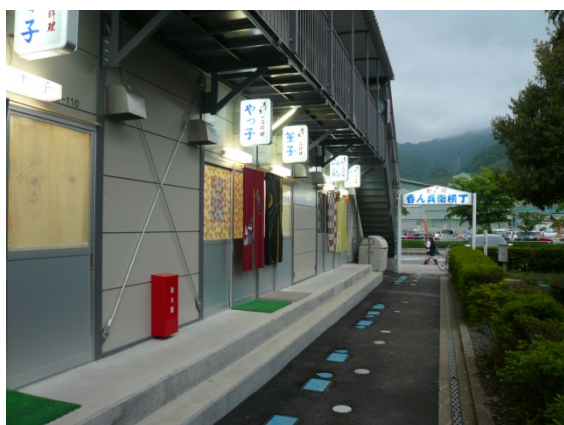
図 3.40 : B棟呑兵衛横丁の外観
