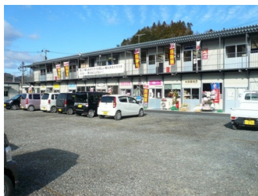
図 1.3 : 仮設商店街の例 (岩手県大槌町)
