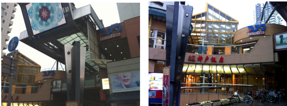
図 2.6,2.7：アスタくにつか1番館、2番館の外観
