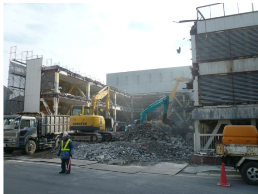
図 3.32：解体工事がはじまった立体駐車場（2012年11月撮影）
