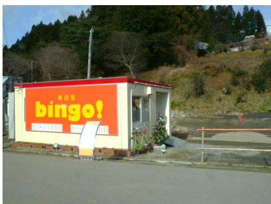
図 1.2 : 仮設店舗の例 (岩手県陸前高田市)
