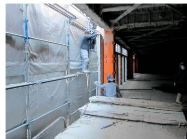
図2. 事例A 外壁解体の様子
