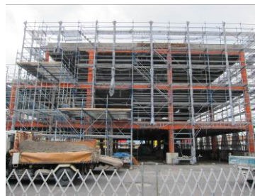
図1. 事例A 解体工事後の外観
