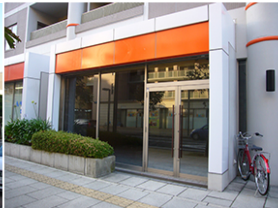
写真 3-6 空室の店舗区画（筆者撮影）
