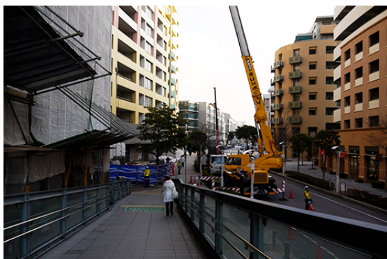
写真 2-1 修繕工事が実施されている住棟①(筆者撮影)
