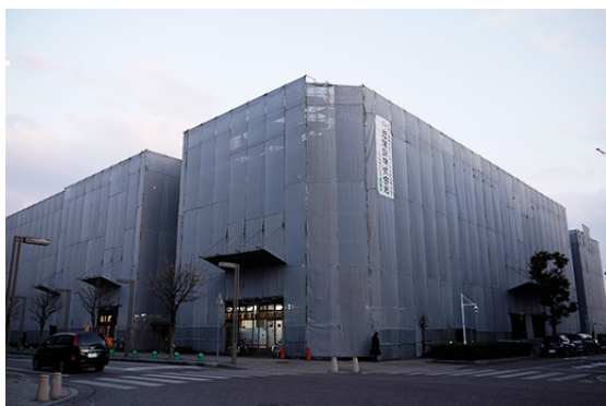
写真 2-2 修繕工事が実施されている住棟②(筆者撮影)
