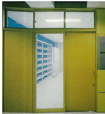
図 4-4-4 : 閉鎖的になりがちな研究室内部を可視化するガラス開口
