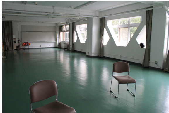
図6-6 耐震補強がなされた壁
