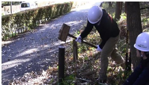
(図 3-10 作業風景 左上：柵作りに用いた道具 右上：古い杭を引き抜く 左下：新しい杭を打ち込む 右下：杭にロープを通す )
