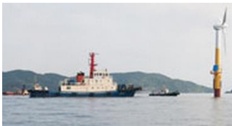
Fig. 1.8 五島沖に設置された浮体式洋上風車「はえんかぜ」[10]
