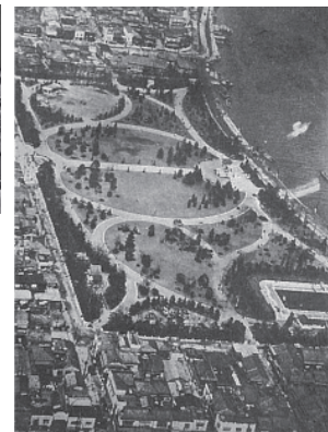
図 63 竣工当時の浜町公園
