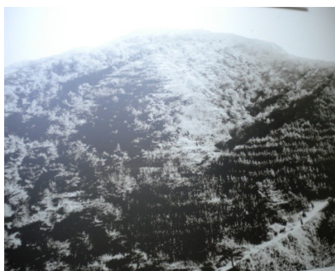
施工 5 年後の再度山（2010.06.08）
