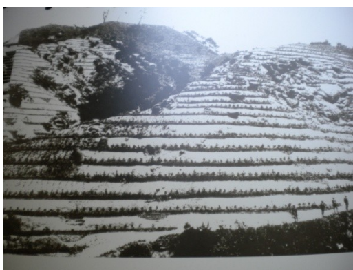
施工 1 年後の再度山（2010.06.08）
