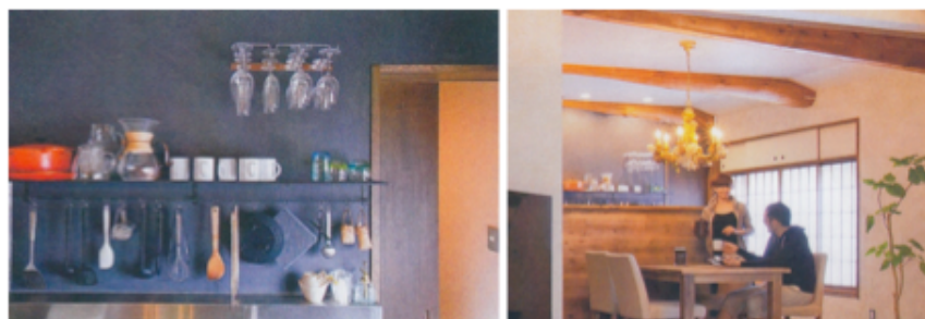
図 15 「墨を混ぜたモルタルを塗」ったキッチンの壁 (LiVES 71号 p.32)
