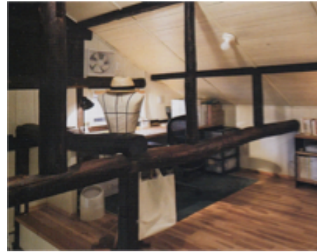
図 22 「囲炉裏の煙で燻され」た柱梁 (LiVES 72号 p.51)
