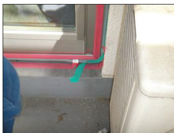
▲図 N-21. 水抜き孔をコーキング材が 塞がぬようマスキングテープが 貼られている
