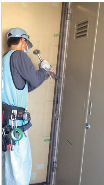
▲図 N-38. 表出したモルタルを研る
