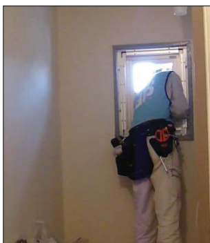
▲図 N-96. 外側も室内から 覗き込んで施工する。
