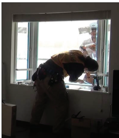
▲図 T6-8. マスキングテープを貼り(手前の人)、 シール材をうつ(奥の人)。 両面で同様の作業を行っていた。
