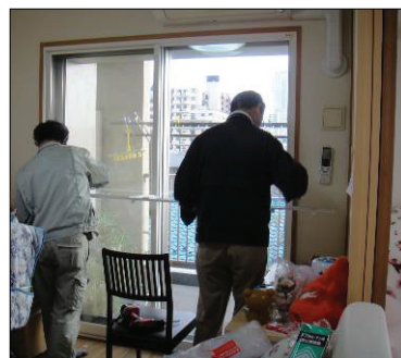
▲図 H－6. カーテンレールを取付ける様子
