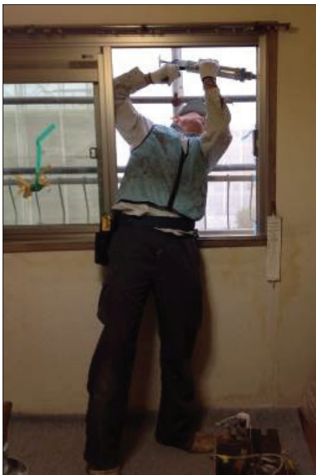
▲図2-1-16. 室内から身を乗り出してシール材を打つ様子
