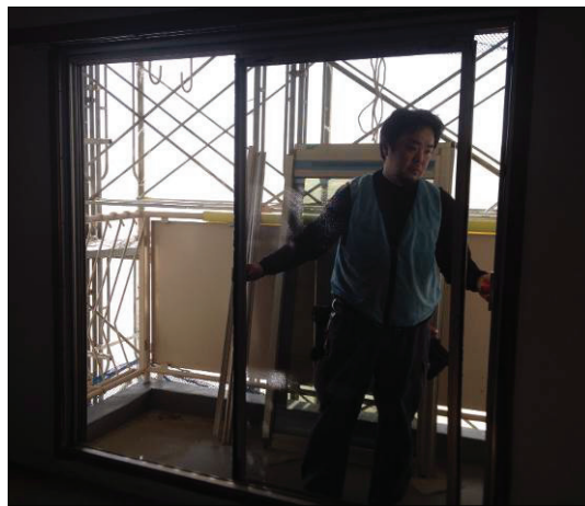
▲図 N－81. 網戸を吊り込んで調整する
