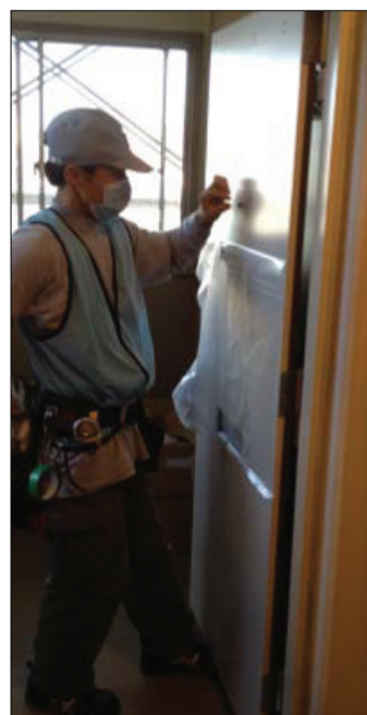
▲図 N-120. 戸の保護シールをはがし、 ドアアイの調整を行う
