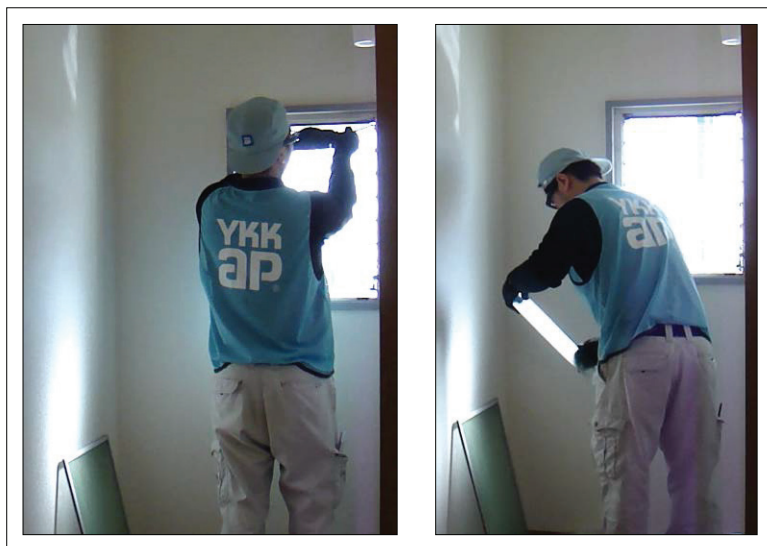
▲図 N－88. ジャロジーガラスの取外し
