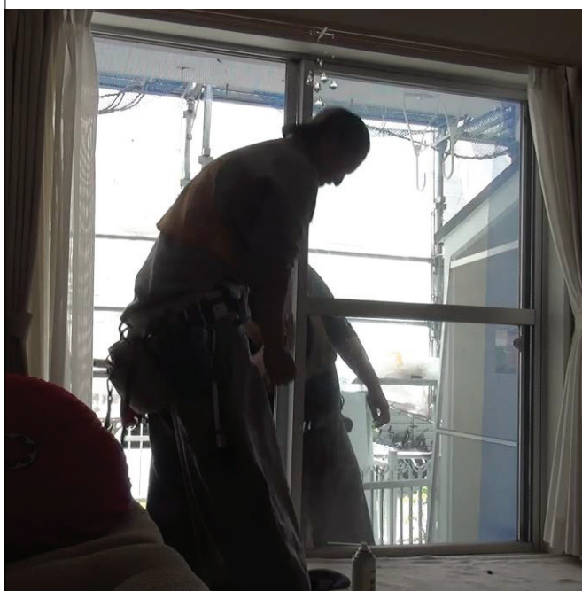
▲図 T-54. 建て付けの調整。既存サッシの開閉操作もしにくかったらしい。
