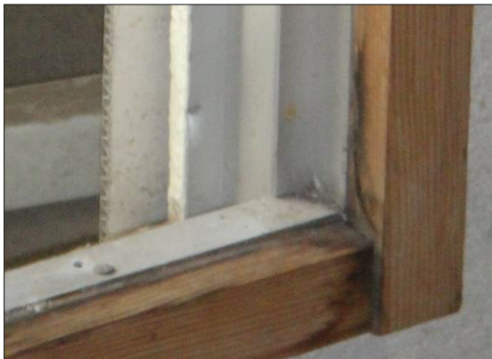
▲図1-1-7. 結露水で傷んだ窓額縁の木材
