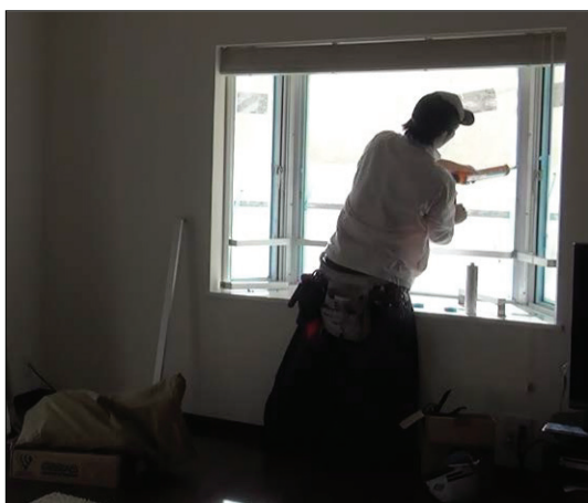
▲図 T6-10. 内側からのシール材打設
