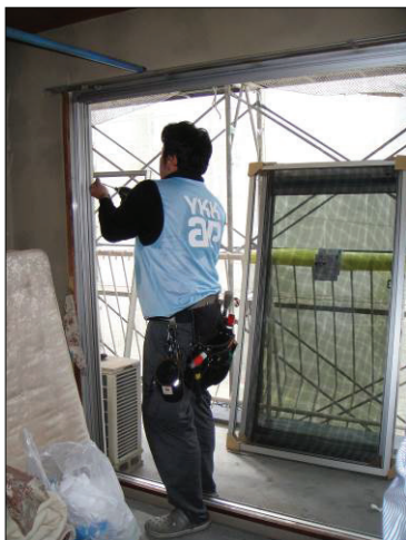
▲図 N-20. 緩衝材を取付ける様子と 新しい障子・網戸
