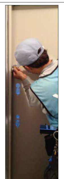
▲図 N-121. ドアガードの取付、内側からの調整
