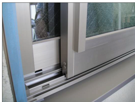
▲図 N-24. 複層ガラスの厚みを飲み込める 障子がないためガラス部分が 出っ張っている
