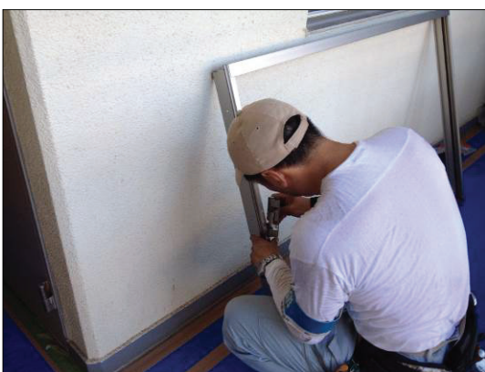
▲図 N-28. 組立てたカバー材に 網戸ストッパーを 取り付ける様子
