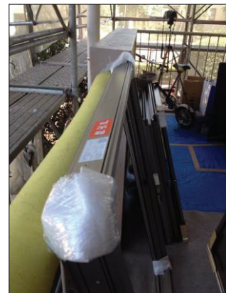
▲図 N-27. 取り付けられるサッシは 防火仕様のもの
