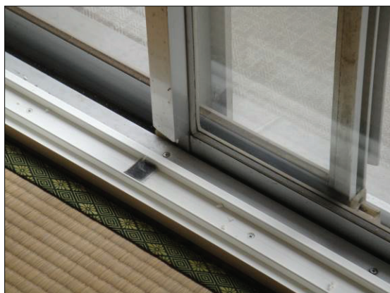
▲図 T-23. 下枠に貼り付けられる気密材
