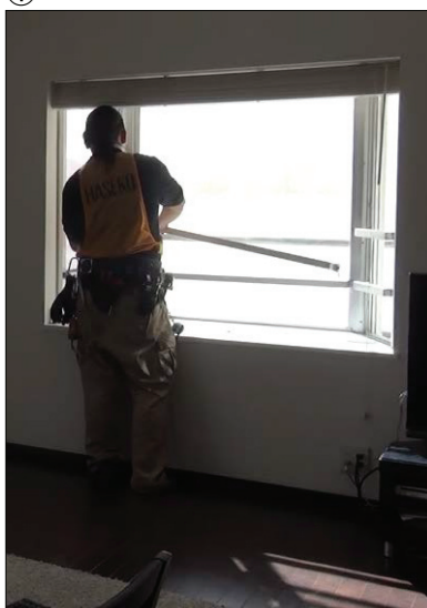
▲図 T6- 2. 窓周りの付加物の一時撤去
