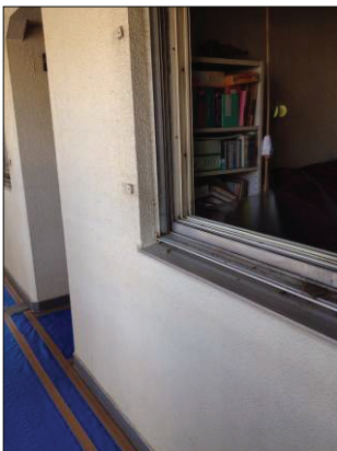
▲図 N-25. 面格子や既存の障子を 外した様子。
