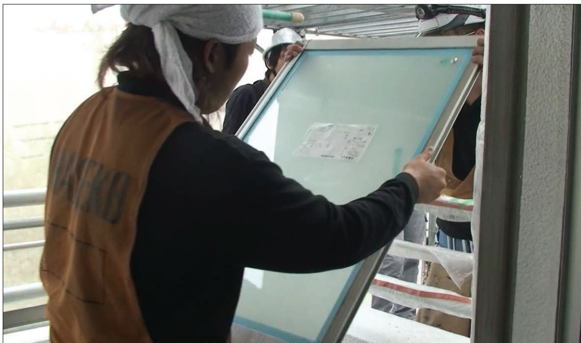
▲図 T5-24. バルコニーで解体・組立した戸の受け渡し
