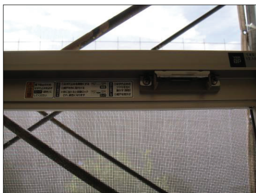
▲図 N-23. 新設網戸の外れ止め
