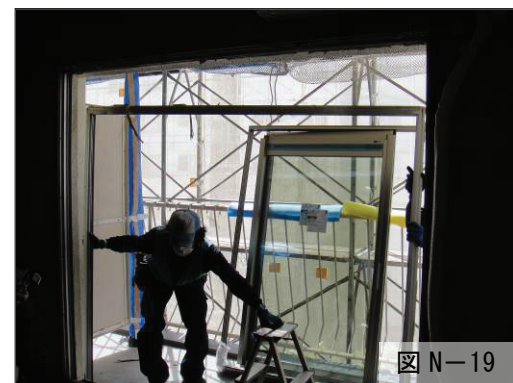
▲新設カバーを取り付ける
