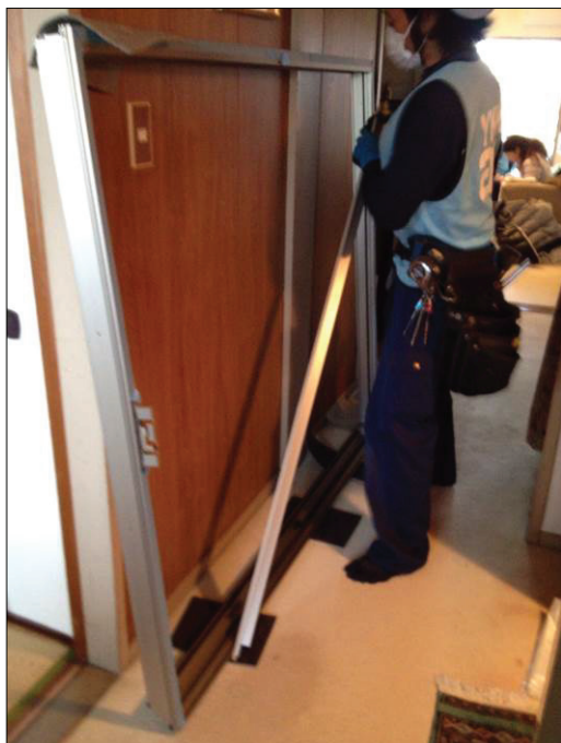
▲図 N-145. 枠を玄関先の通路で組立っている
