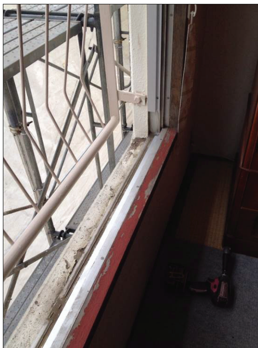
▲図 N-144. 枠材を付けている途中。 ①と同様に下額縁が赤く塗装されている。
