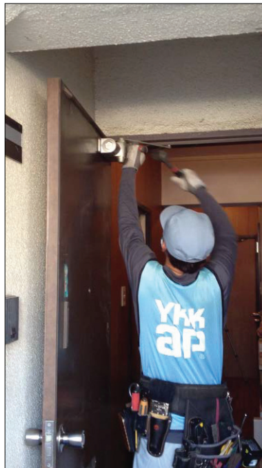
▲図 N-35. ドアクローザーを外す様子
