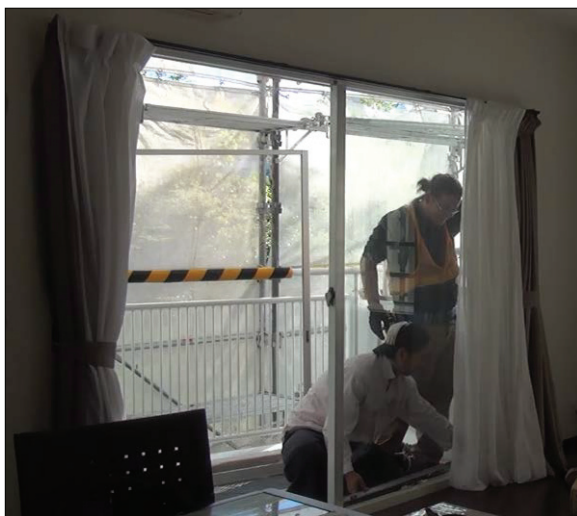
▲図 T6-16. ガラスの四周を固める サッシ部材の取外し
