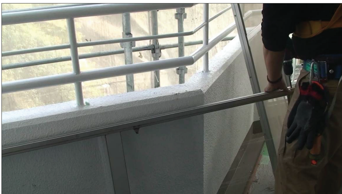
▲図 T5-6．バルコニーでサッシを解体する。
