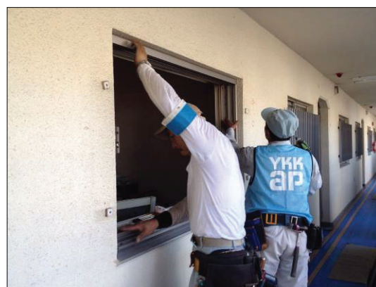
▲図 N-29. カバー材を取り付ける様子
