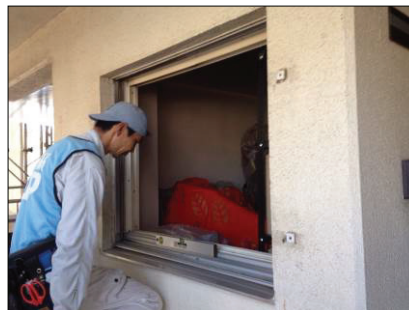
▲図 N-26. 水平器で、 取り付けた緩衝材の 水平を確認している。
