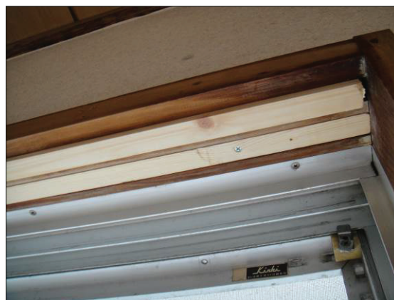
▲図 T-22. 既存和障子枠の溝を木材で埋める様子
