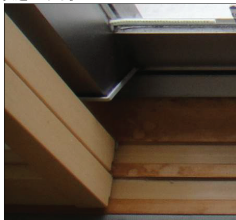
▲図1-1-6. 結露水によってできた木材のシミ
