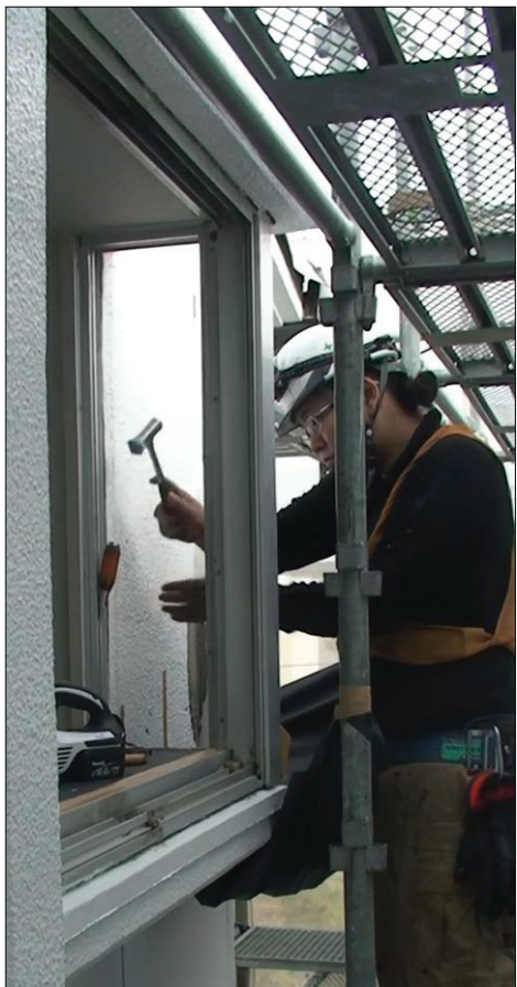
▲図 T5-21. ガラスを嵌める溝に残ったパテを叩き取る。
