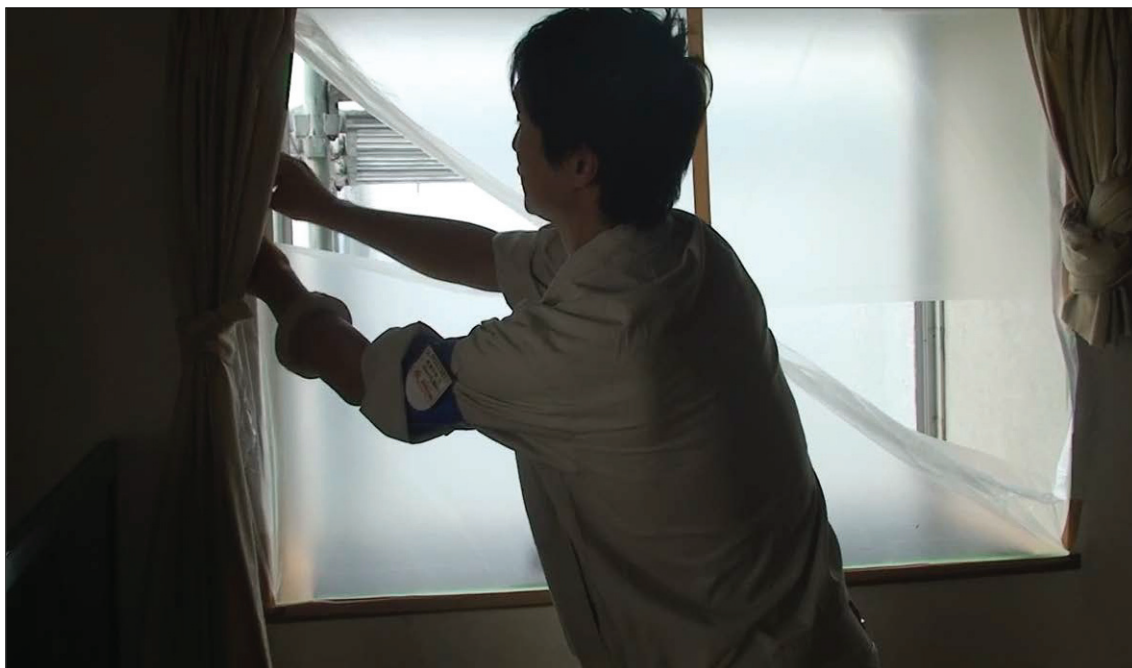
▲図 T5-17. 嵌め殺しの小窓のガラスは割り取る。 室内にガラス片が飛散しないようビニールで養生している。
