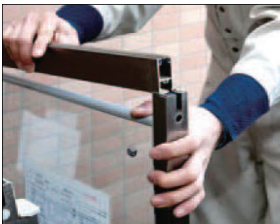
▲図2-1-33. 取付専用グレチャンによる施工
