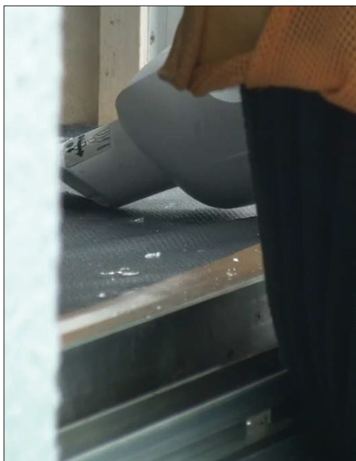
▲図 T5-20. ガラスの破片を掃除機で吸い取る。
