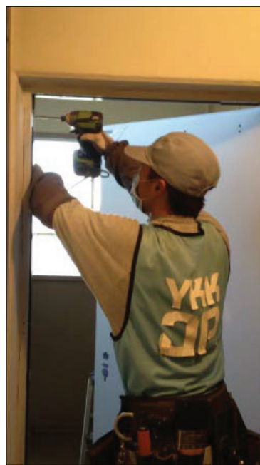
▲図 N－114. スペーサーを挟みながら 新設枠の垂直を出す。
