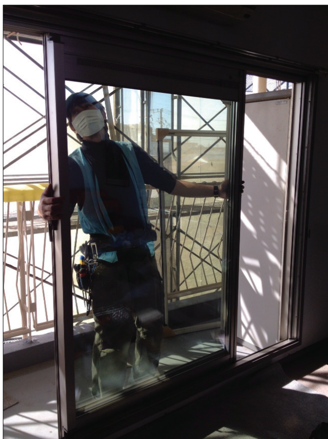
▲図 N－79. 新設障子を吊り込む
