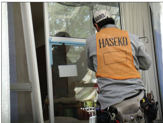
▲図 T-53. サッシとガラスの継ぎ目にコーキングを施す様子
