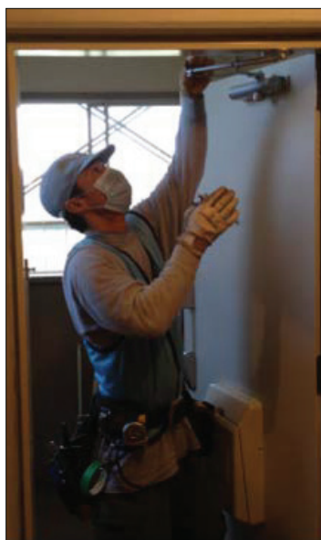
▲図 N-127. ドアクローザーの調整
