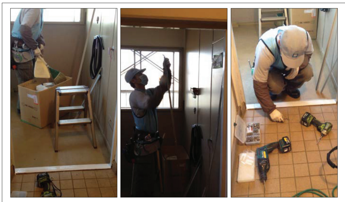
▲図 N－107. 防錆塗料が乾くまでの間、清掃を行ったり(左)、新設枠材の準備をしたり(中)、 枠材を留め付けるためのビスを用意したり(右)する。
