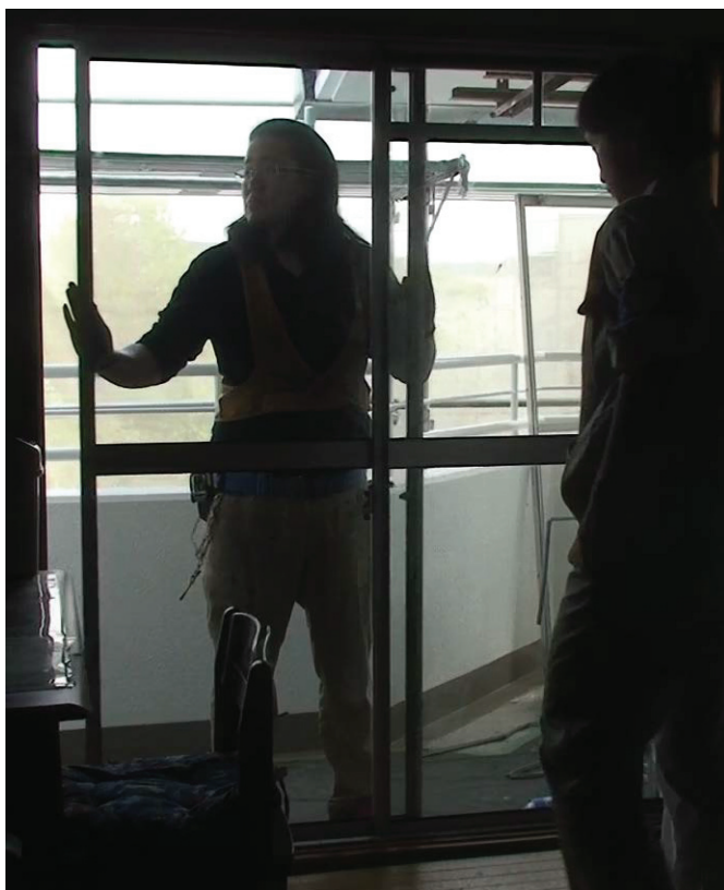
▲図 T5-12. 戸の吊り込み
