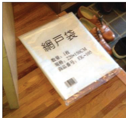
▲図 N－31. シール工事や外壁塗装工事の間、 網戸は汚れないよう 袋に入れられて保存される。
