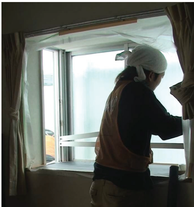
▲図 T5-13. 嵌め殺しの小窓のある出窓。手摺を取り外している。
