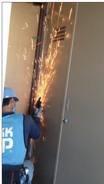
▲図 N-37. ラッチ受け設置のため サンダーで既存枠を切欠く
