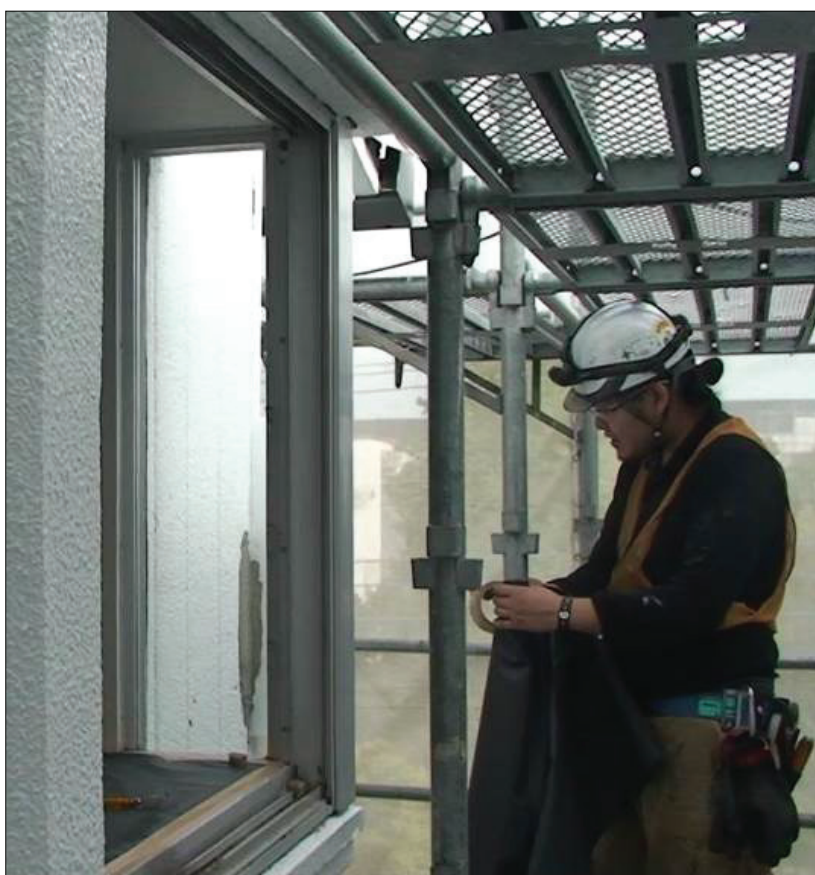
▲図 T5-18. 外でも階下にガラス片が飛び散らないよう養生を行う。
