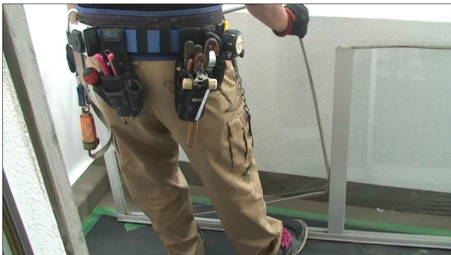
▲図 T5-7. 既存ガラスの取外し
