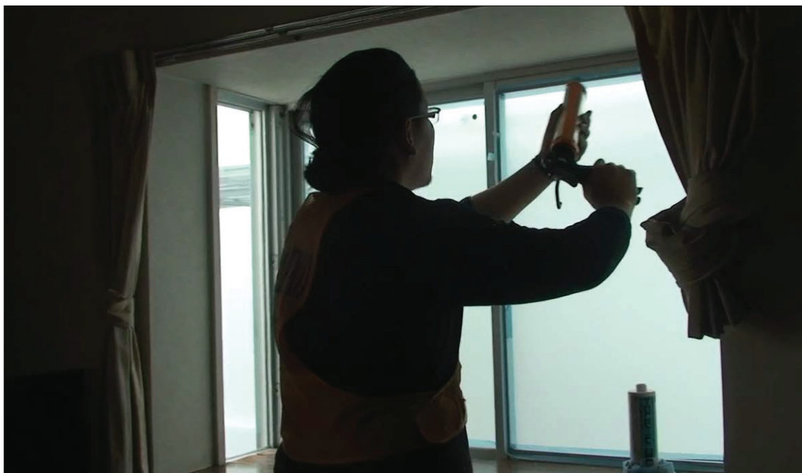
▲図 T5-26. バルコニーで組み立てた戸へのシーリング材の打ち込み
