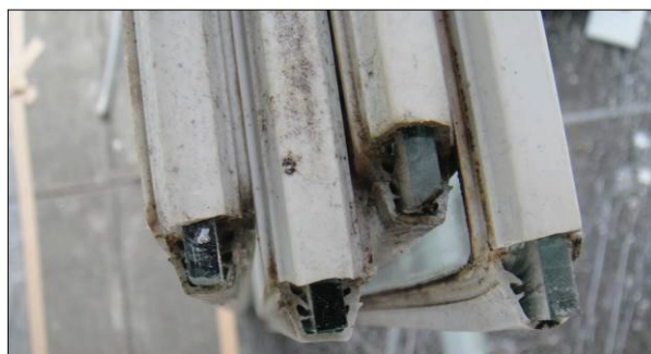
▲図 T-49. 取り出された既存ガラスの詳細。 汚れがたまっている。
