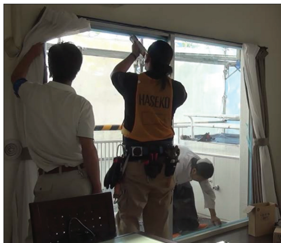
▲図 T6-28. マスキングテープ貼付後、 シーリング材の打設。
