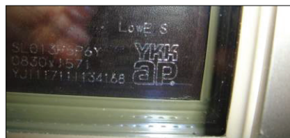
▲図 N-15 サッシ製造 Y の ロゴ入り low-E 複層ガラス
