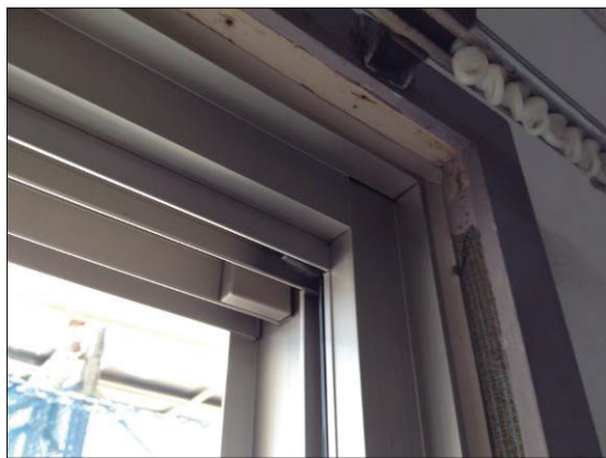
▲図 N－71. 施工後の枠の様子。既存木額縁に傷みが見られる。
