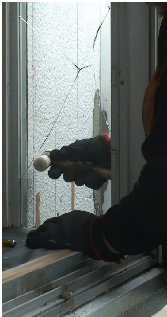
▲図 T5-19. カッターで切れ目を入れ、木槌で叩いてガラスを割り取る。
