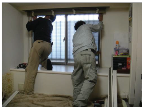
▲図 H－7. 2人で1窓施工する様子
