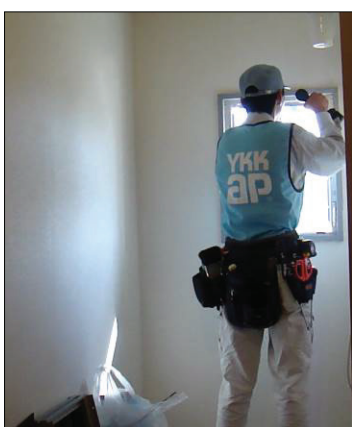
▲図 N－90. 枠材のビス留め
