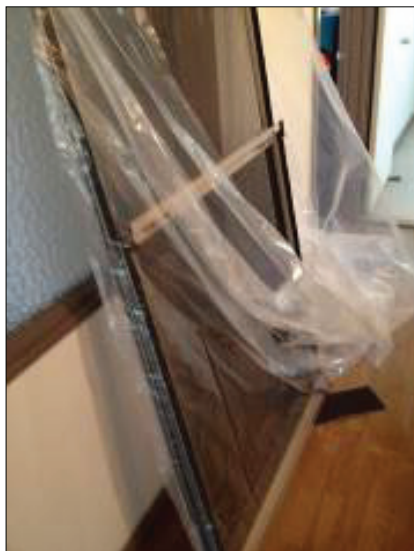
▲図 N－103. 外壁塗装の間汚れないよう、 網戸を袋に入れて保管する。
