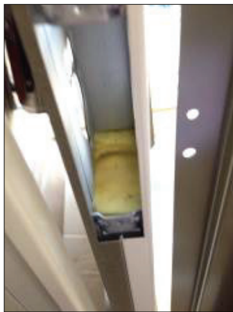
▲図 N－105. 新設の戸には一部 断熱材が入っている。
