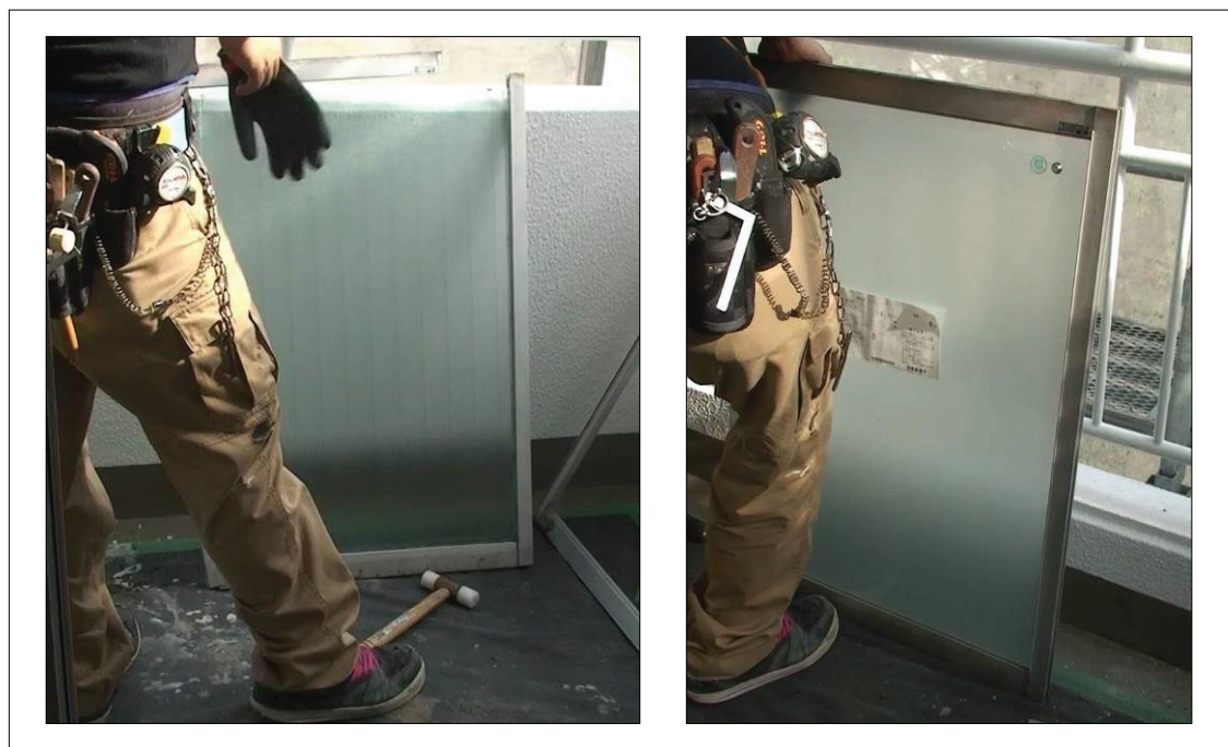
▲図 T5-14. バルコニーに戸を運んで解体・組立を行う。
