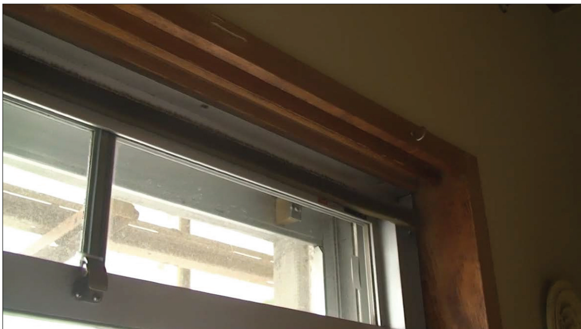
▲図 T5-3. 既存窓詳細。換気用小窓がある。
