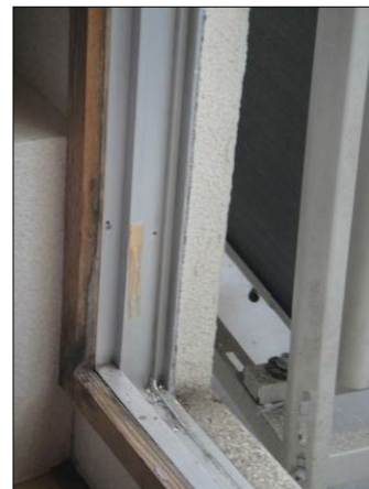
▲図 N-57. 飼木が接着剤で接合されていた跡
