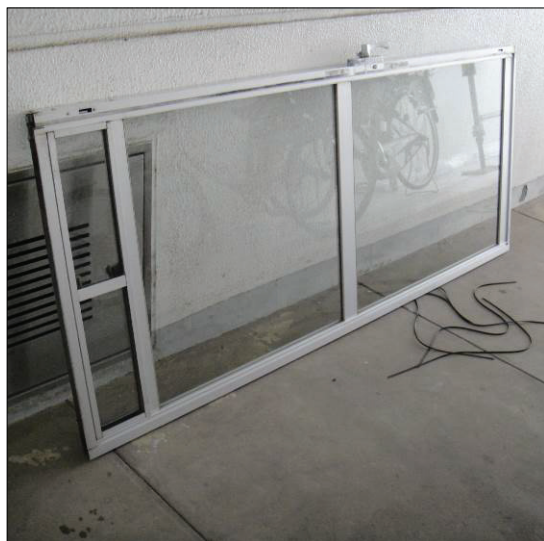
▲図 T-50. 小窓付サッシとその分解の様子。小窓のガラス交換は行われない。
