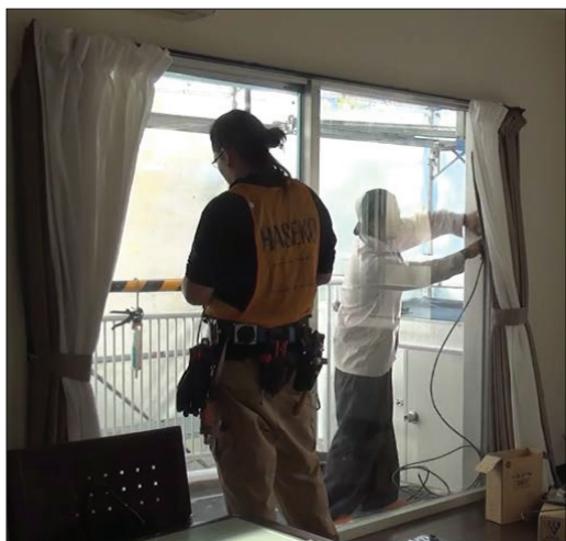
▲図 T6-27. 気密材の詰め込み。
