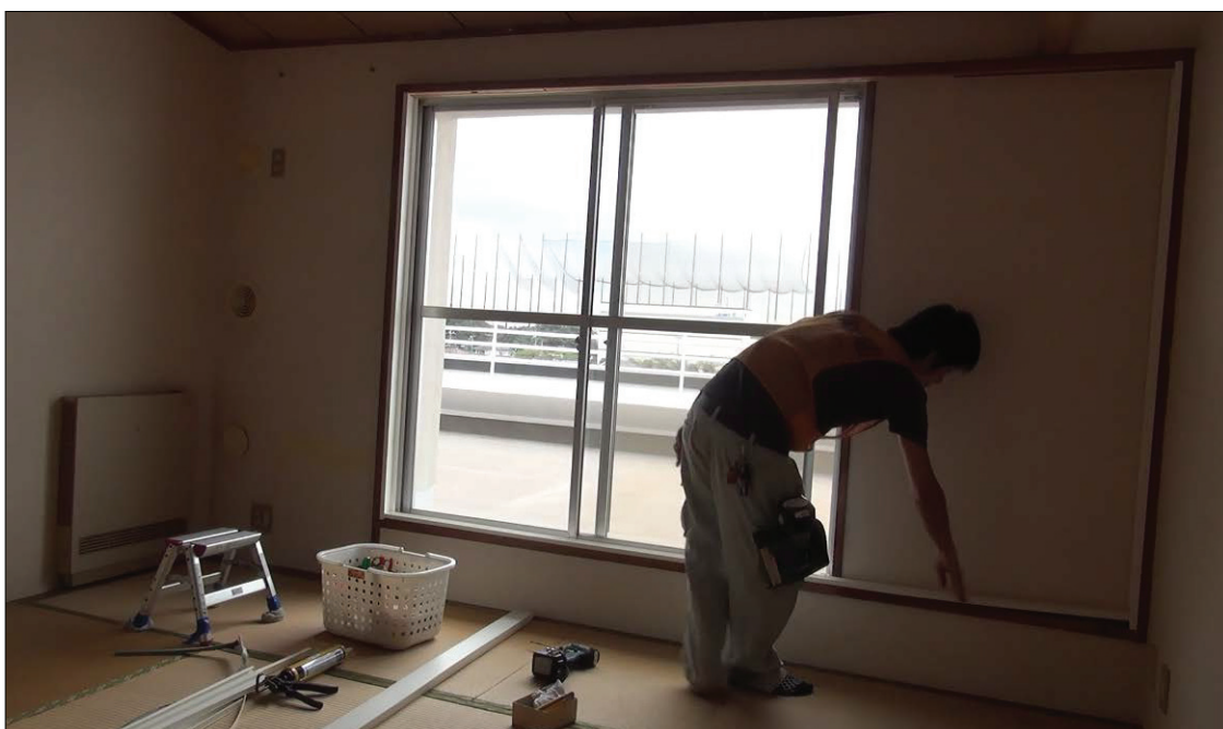
▲図 T-30. 既存和障子の枠の上に枠を取付ける様子。開放時に戸袋を利用できる。
