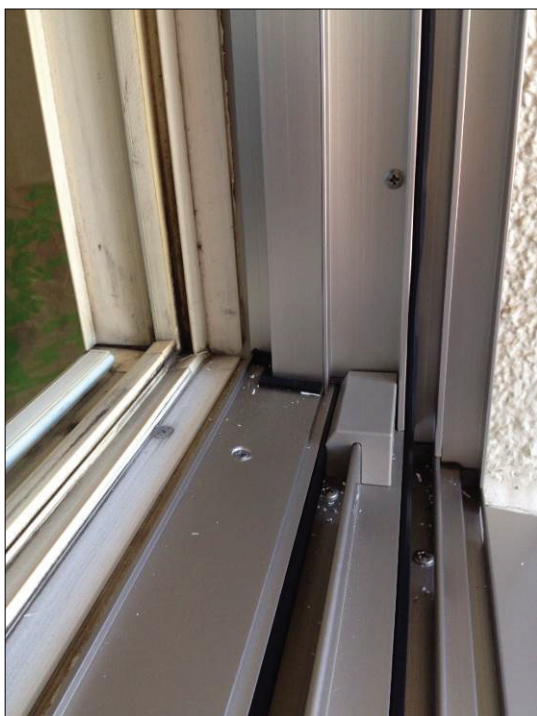
▲図 N－32. 新設枠と既存内窓枠の 取り合いの様子。
