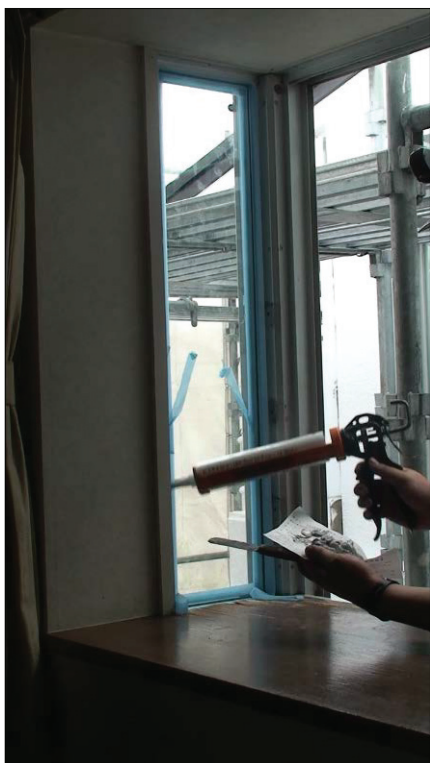
▲図 T5-23. シーリング材の打ち込み
