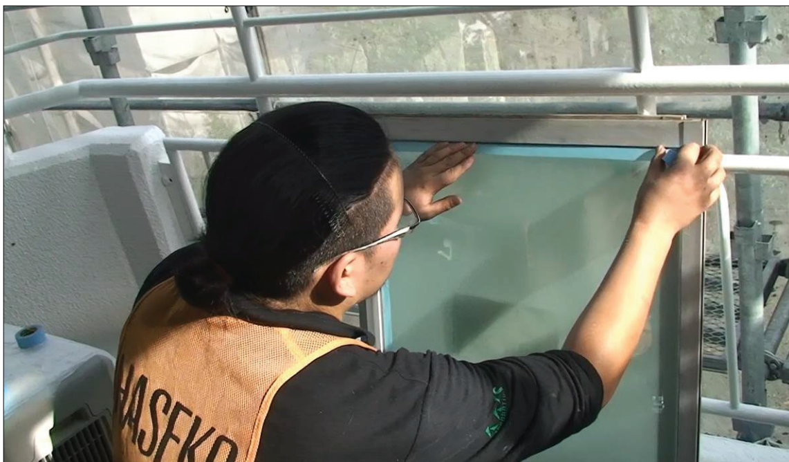
▲図 T5-16. ガスケットの代わりとなるシーリング材を打つためにマスキングテープを貼る。
