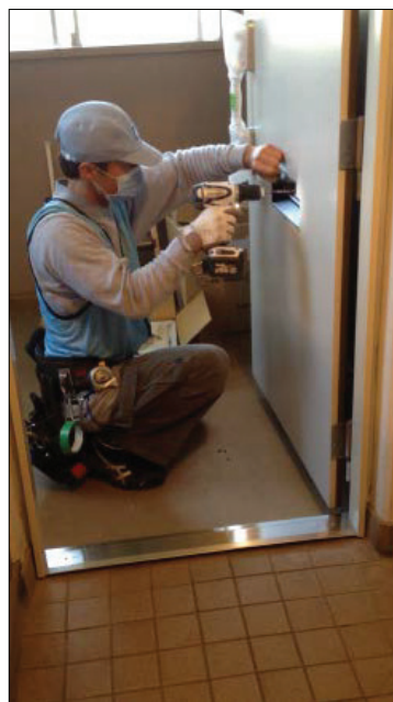
▲図 N-125. ポスト部材の取付
