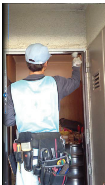
▲図 N-40. 防錆塗料の塗布 (既存枠が スチールのため)
