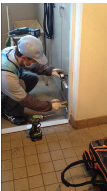
▲図 N-109. 下げ振りで垂直を出す
