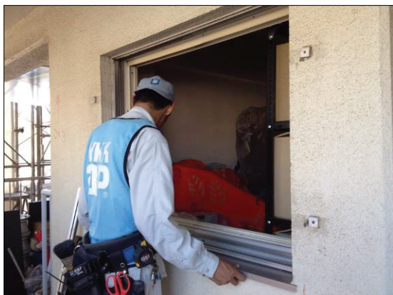
▲図 N－30. 水切り材を取り付ける様子
