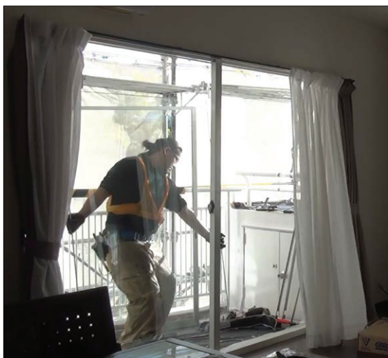
▲図 T6-19. 新設ガラスの搬入。 1人が靴を運んでいる間、 もう1人が支えて待っている。
