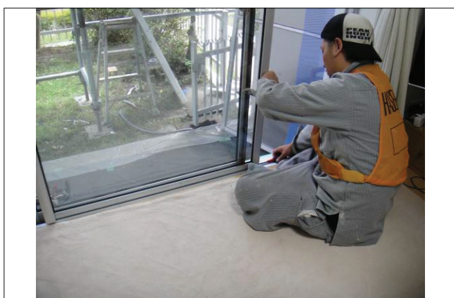
▲図 T-53. サッシとガラスの継ぎ目にコーキングを施す様子
