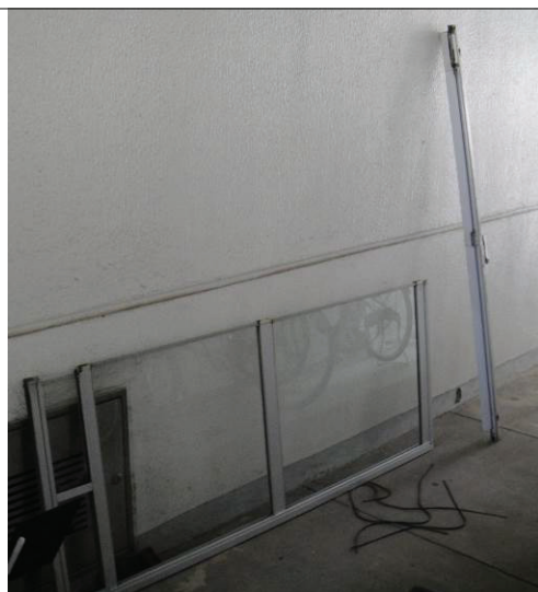
▲図 T-50. 小窓付サッシとその分解の様子。小窓のガラス交換は行われない。
