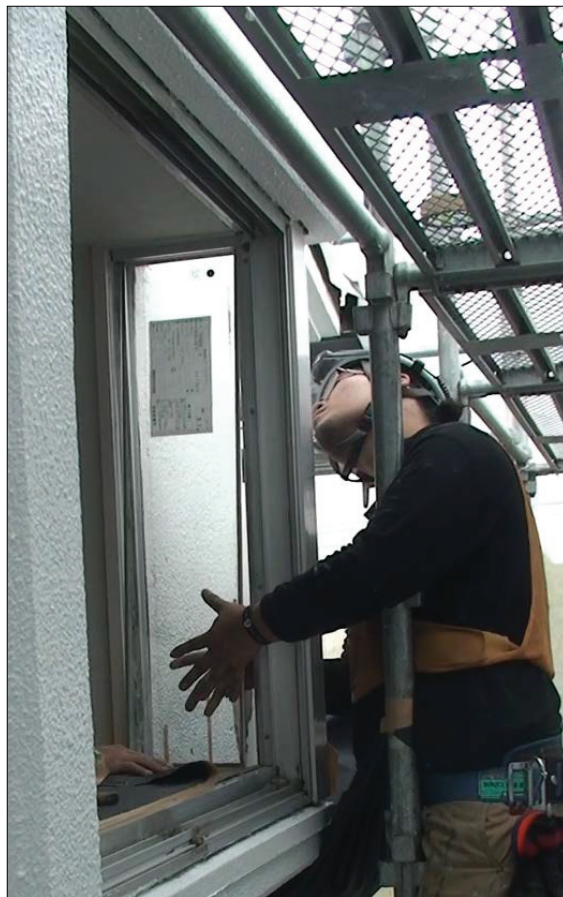
▲図 T5-22. ガラスを微調整しながら嵌め込む
