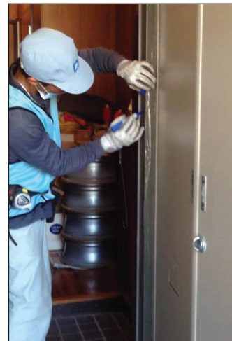
▲図 N-36. ラッチ受け設置のための 切欠き位置を印づけする
