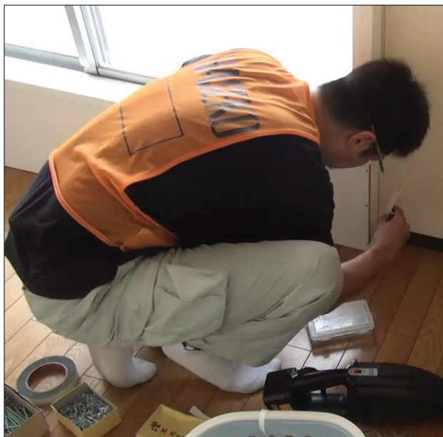
▲図 T-37. 化粧材突き合わせ部分にコーナービードを貼る様子
