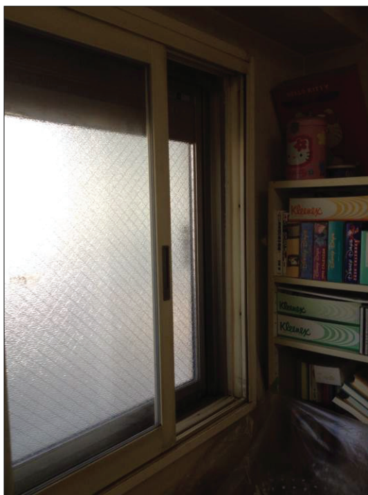
▲図 N－33. 施工後の様子。 既存内窓と新設外窓が 干渉せず丁度良く納まった。
