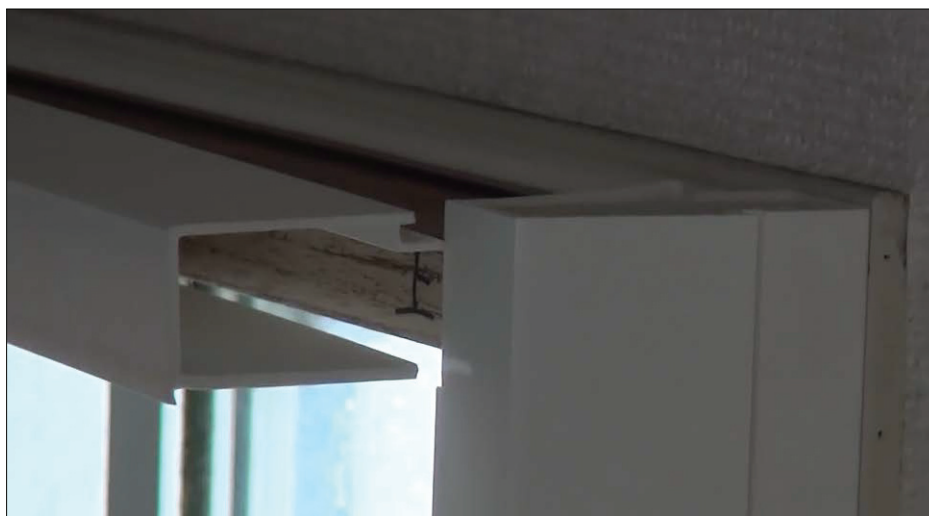
▲図 T-27. 位置指定されている木材に増し枠被せ材を取付ける様子
