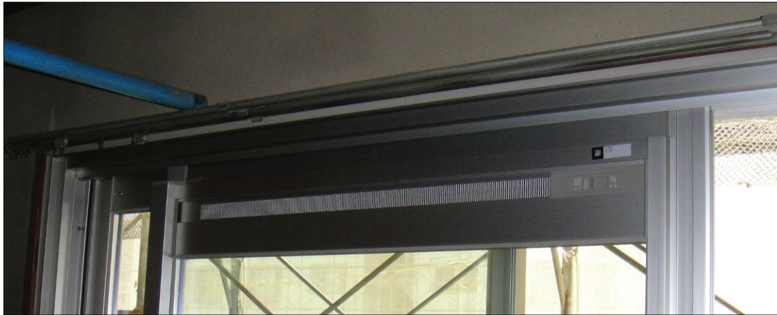
▲図1-1-10. 換気用ガラリの付いた框
