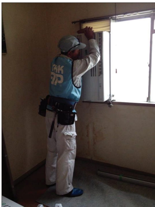
▲図 N-131. ウィンドウクーラーを外す様子
