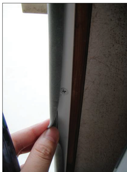
▲図 T-32. 戸袋見切り部に取り付けられた気密材
