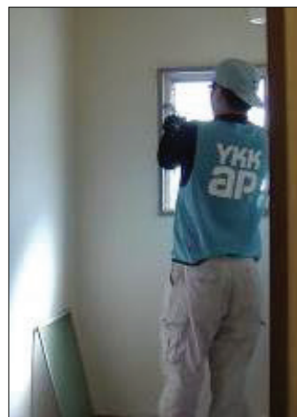
▲図 N－87. 既存金具の取外し
