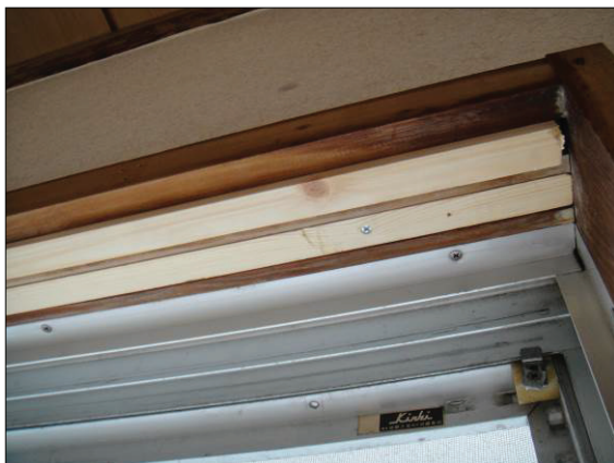
▲図2-1-44. 既存和障子の枠を、取付ける額縁として利用するため、木材で溝を埋めている
