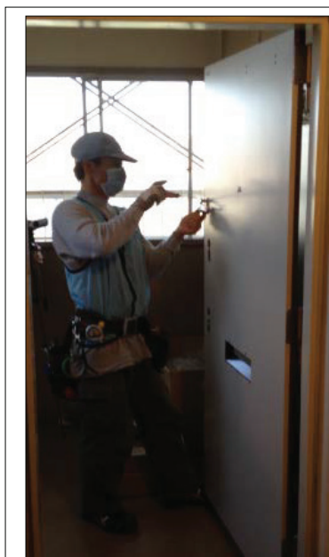
▲図 N-121. ドアガードの取付、内側からの調整
