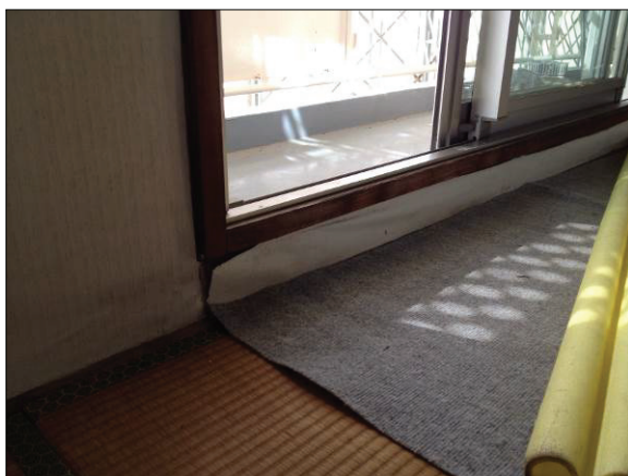
▲図 N－82. 新設障子と養生材。壁紙が結露で傷んでいるようである。
