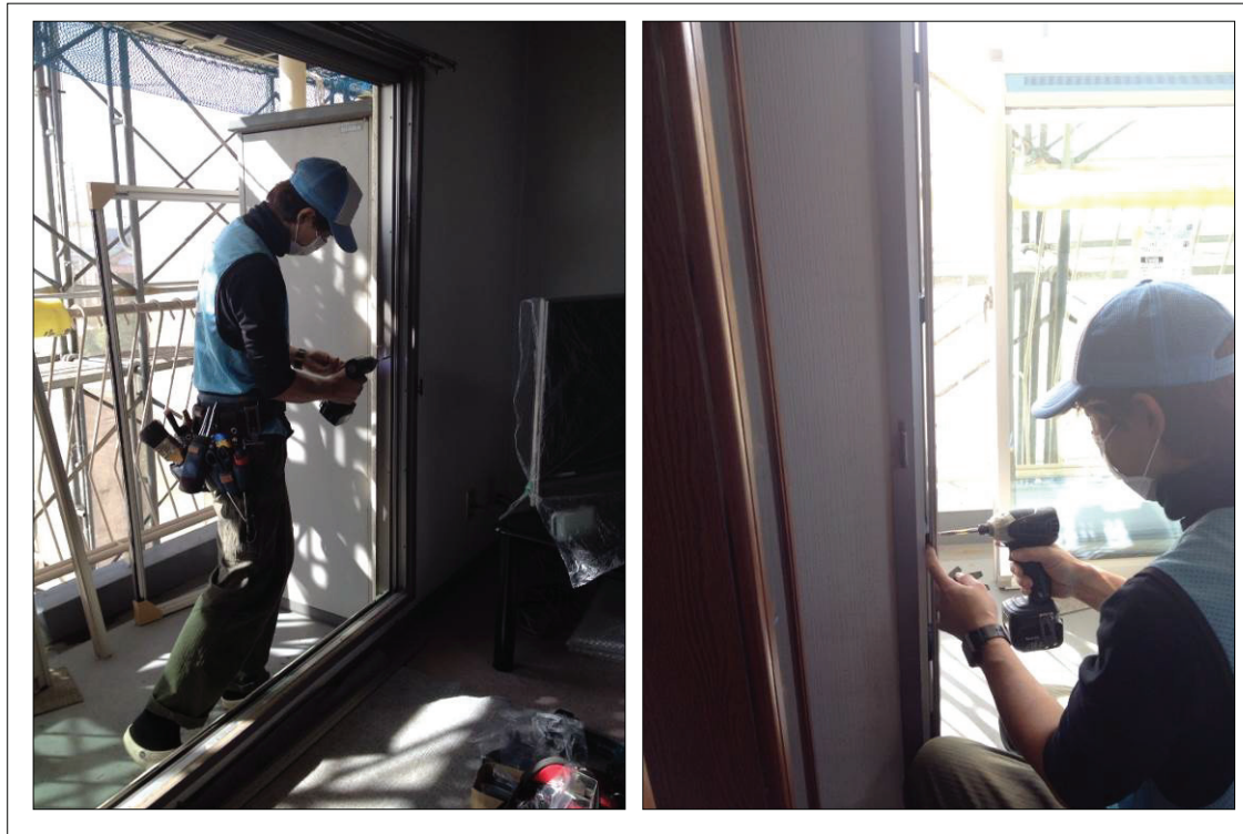
▲図 N－78. 既存枠にビス穴をあけ、枠材を取付け、水平・垂直の微調整をする
