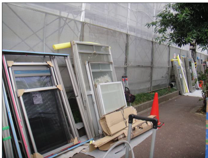
▲図 N-65. 階段室型住棟のため、資材は住棟前に集積されている。 片廊下型住棟の場合は共用廊下に資材が置かれていた。
