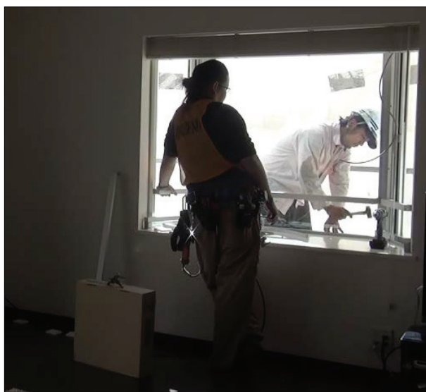
▲図 T6-7. 木槌で叩いてサッシ部材を嵌め込む。
