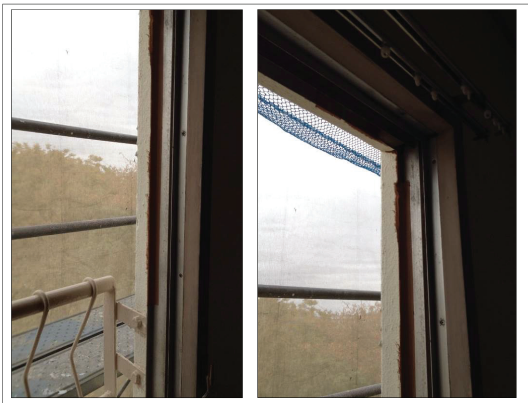
▲図 N-133. 網戸を固定していたガムテープの跡
