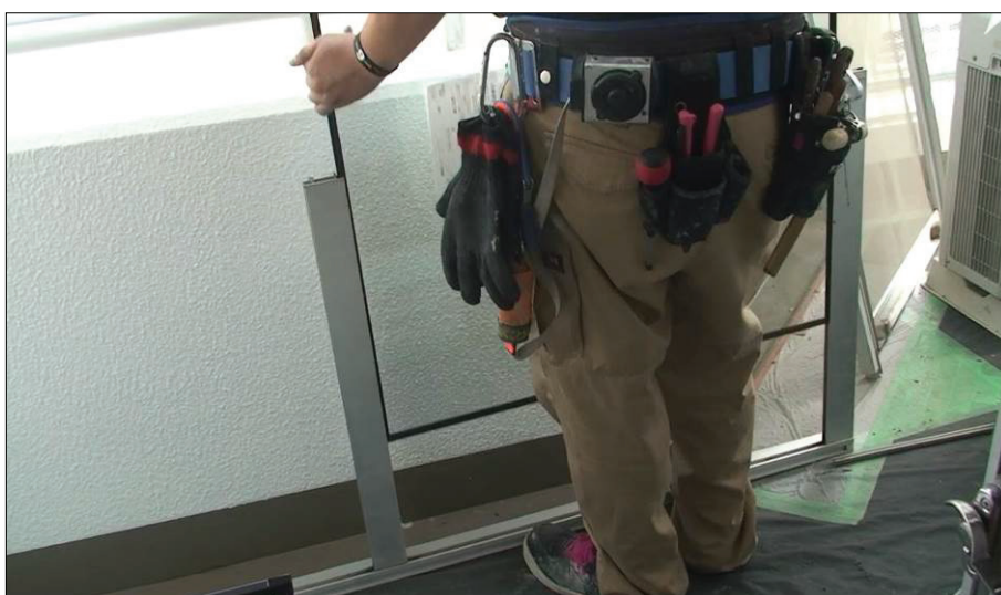
▲図 T5-9. 新設ガラスの嵌め込み
