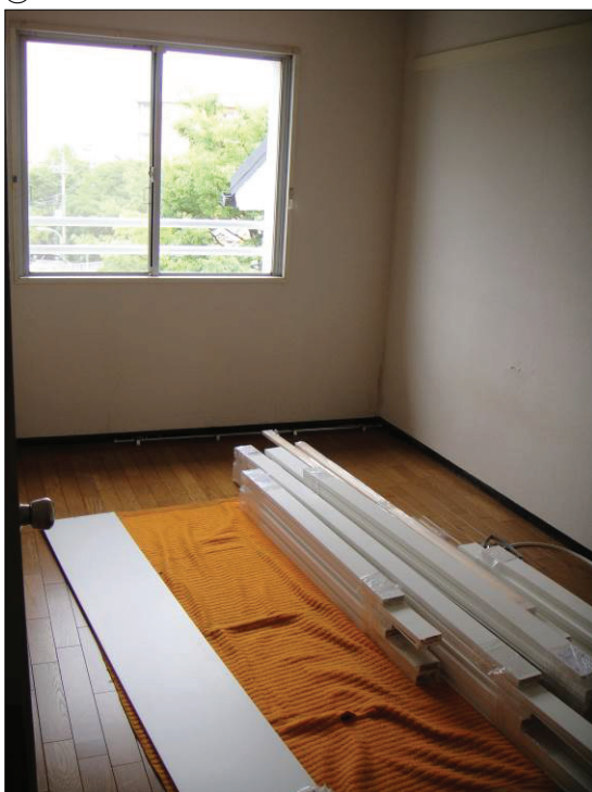
▲図 T-13. 既存サッシ、 予め外されていたカーテンレール、 搬入済みの枠、⑦の束を隠す板など
