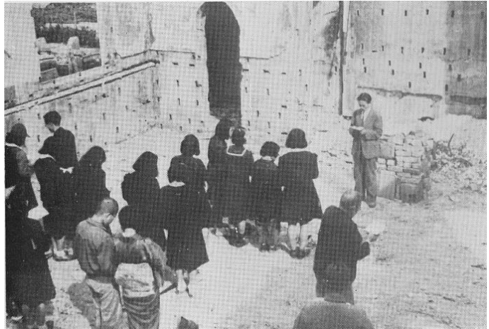
写真6 流川教会の焼け跡での礼拝風景
