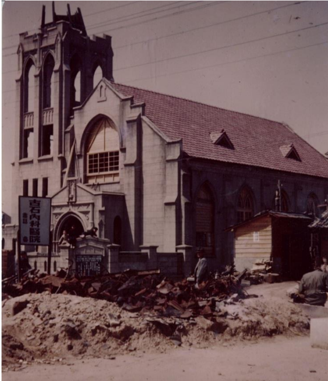
写真7 屋根の修理後の流川教会。鐘樓の修理は未着手
