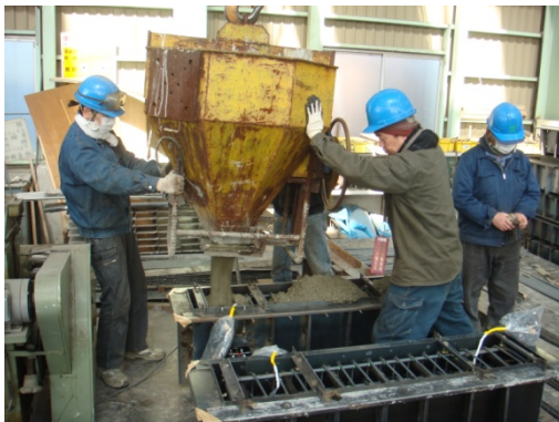
(c) コンクリート打設の状況
