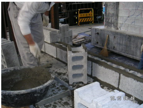
写真 2.1 ブロック造壁の組積様子
