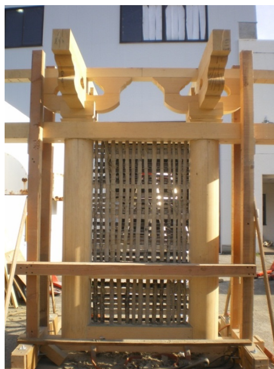
(iii) 北面、全土壁を剥がした後
