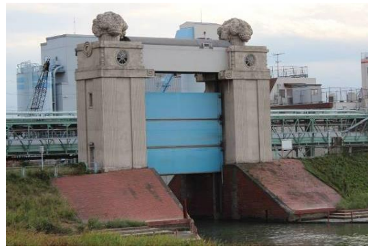
図 1-14 川崎河港水門
