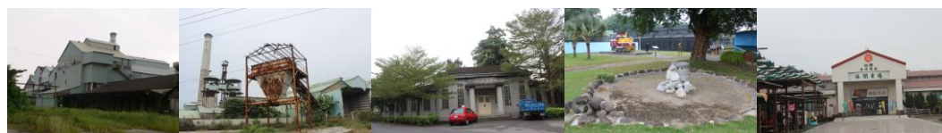
図 4-100 南靖製糖工場の保存現状
