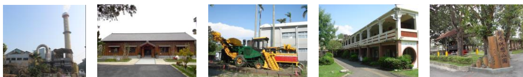
図 4-96 湾裡製糖工場の保存現状
