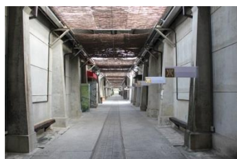
図 4-131 倉庫群の中の通路
