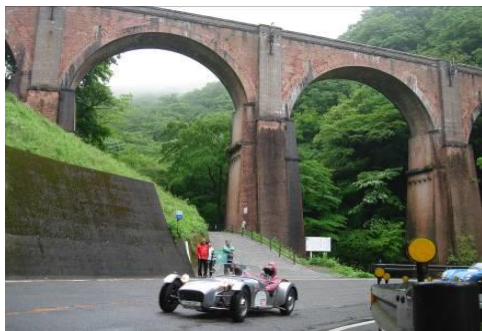
図 1-11 碓氷峠鉄道施設の第三橋梁
