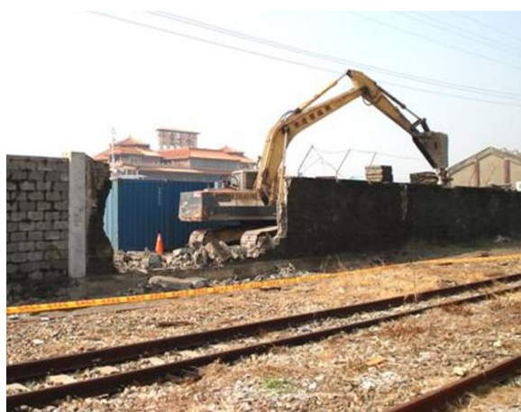
図 2-16 3号船渠周辺の垣根を撤去する様子 (出所：高雄政府都市發展局の提供)
