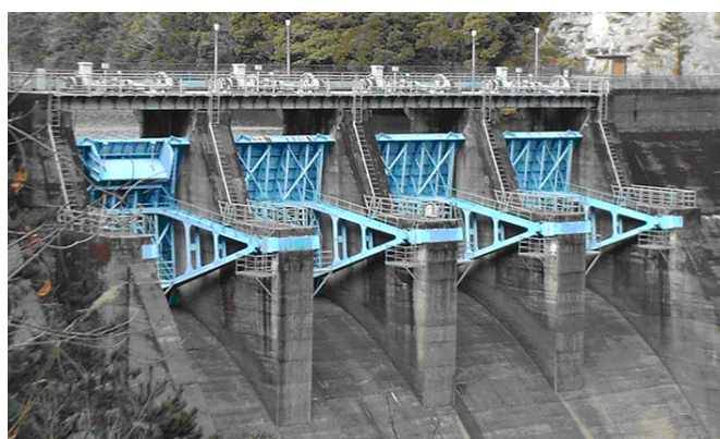
図 3.2 A ダム洪水吐きラジアルゲート
