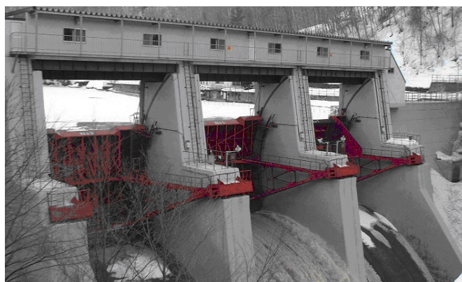
図 3.3 B ダム洪水吐きラジアルゲート
