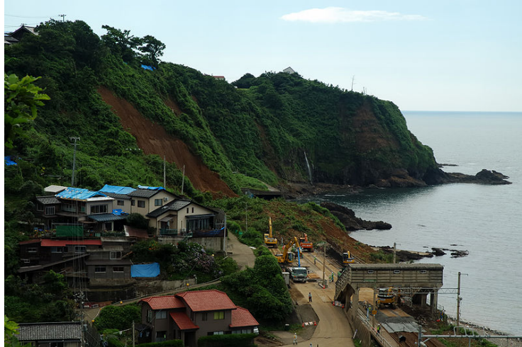
図1.1.1 新潟県中越沖地震での信越本線・青海川駅付近での斜面崩壊 ( http://ja.wikipedia.org/wiki/ から引用)
