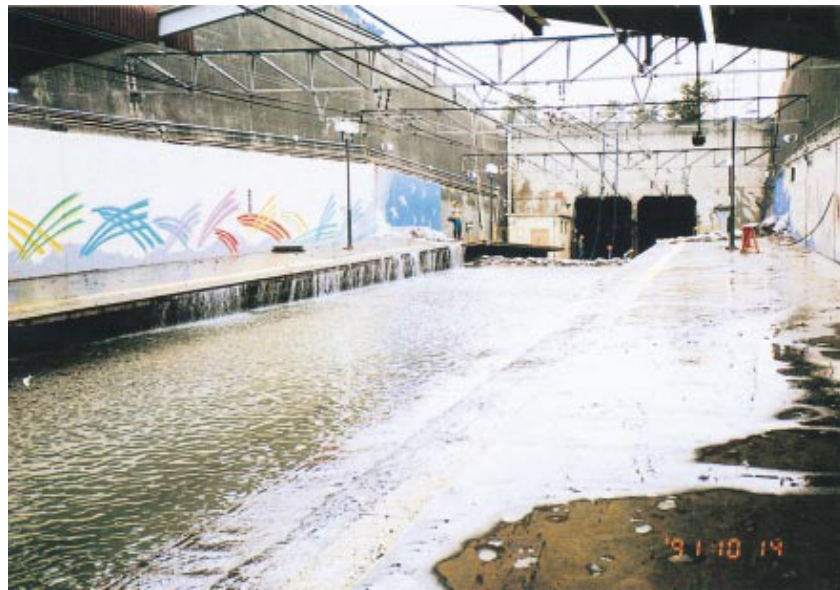
図1.1.5 武蔵野線新小平駅での浸透流による被害
