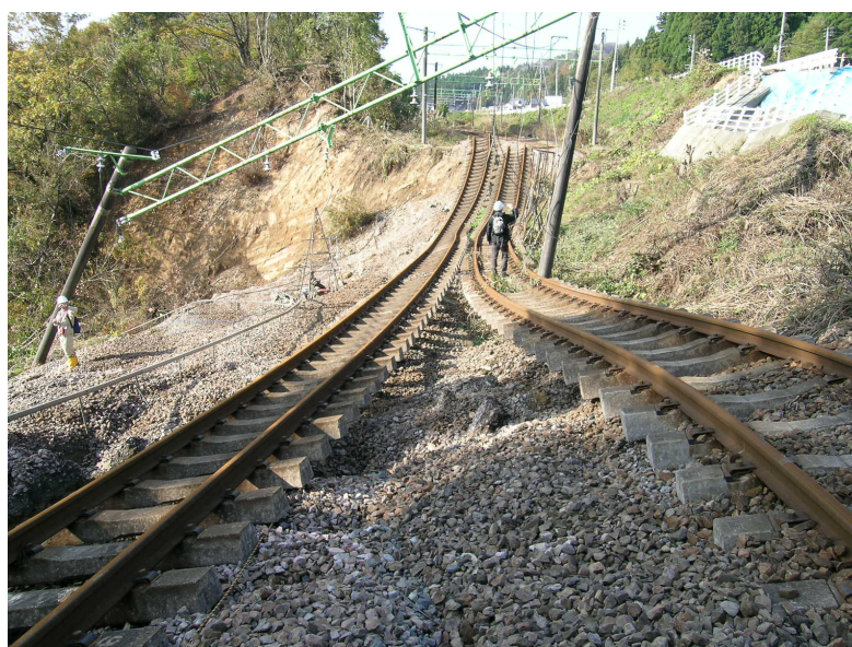
図1.1.4 新潟県中越地震における上越線221km000m付近での盛土崩壊
