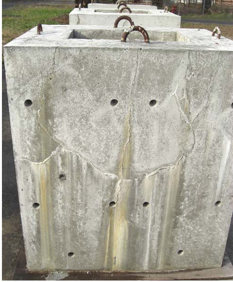
写真 5.6 通水 1 年後の桁形 RC 試験体
