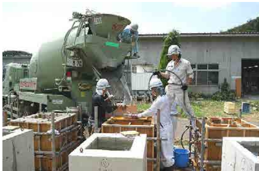
写真 4.7 桁形 RC 試験体の打設の様子
