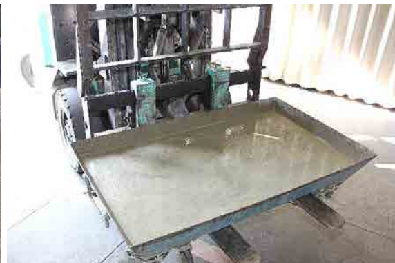
練上り直後の遅延剤入り高流動モルタル
