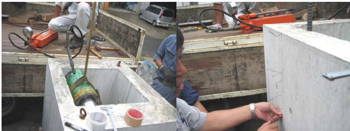
ジャッキによるひび割れ開口
