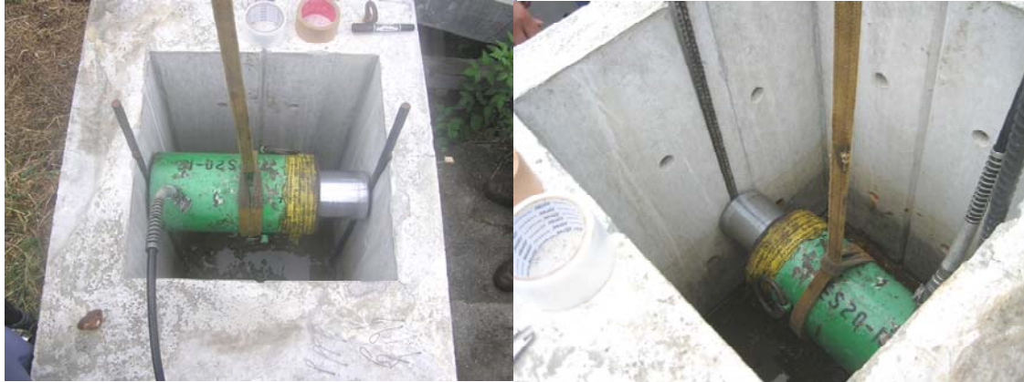
ジャッキによるひび割れ導入(上部) ジャッキによるひび割れ導入(下部)
