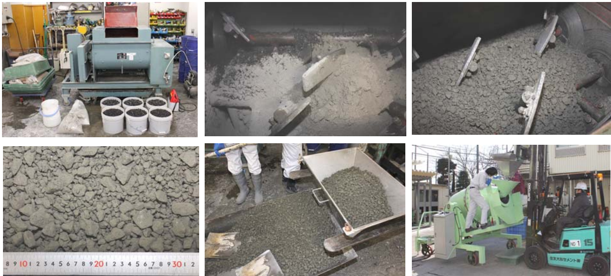
写真 7.6 第1工程 コーティング粗骨材 (増粘剤+硬化促進剤を使用) の製造
