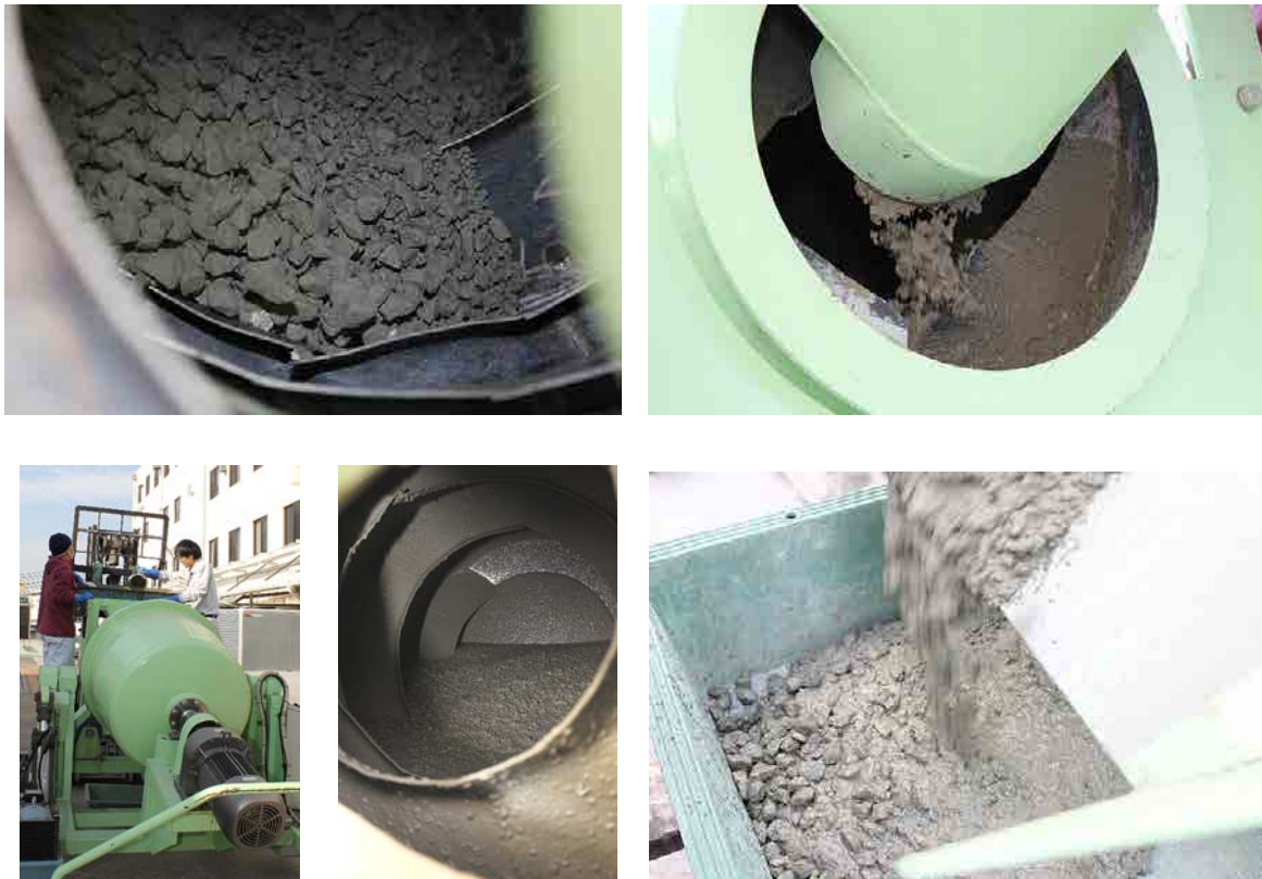
写真 7.9 連続製造プロセスによる自己治癒コンクリートの製造の様子
