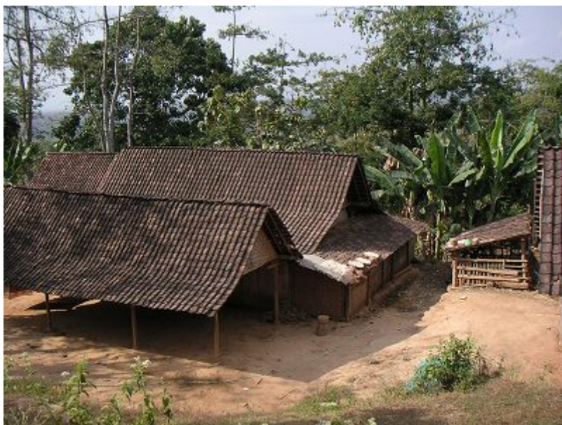
写真 2-2-20 調査した RT 内の家屋
