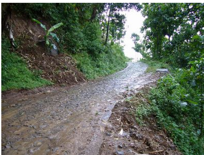
写真 4-1-10 集落内の道路
