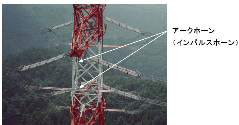
図 1-10 UHV 架空送電線のアークホーン（インパルスホーン）
