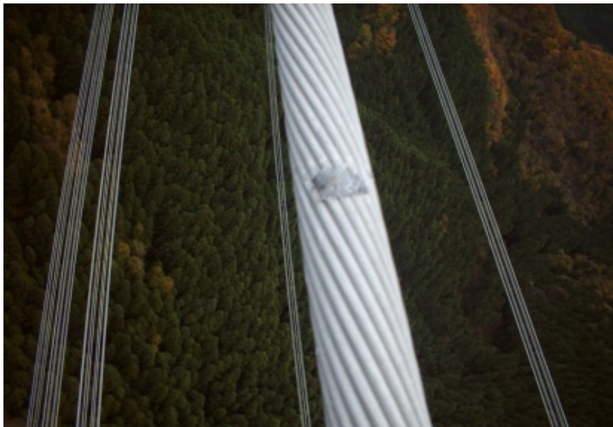
図 2-12 OPGW500 mm 2 の被害状況(2L)
