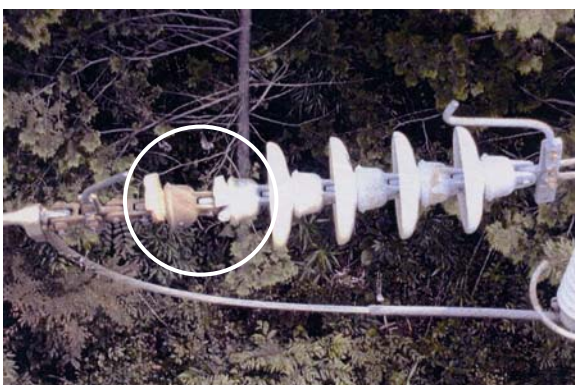
図 1-3 がいしの被害事例（笠欠け）
