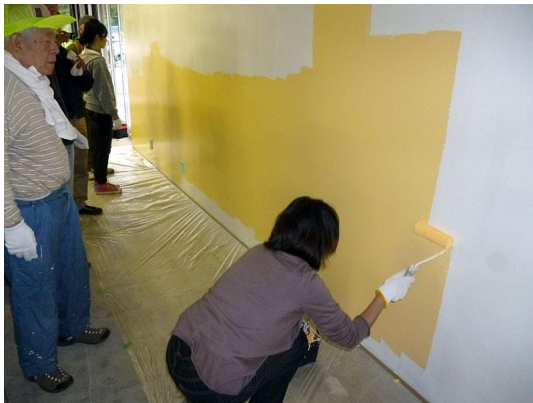
写真 セルフビルドの様子
