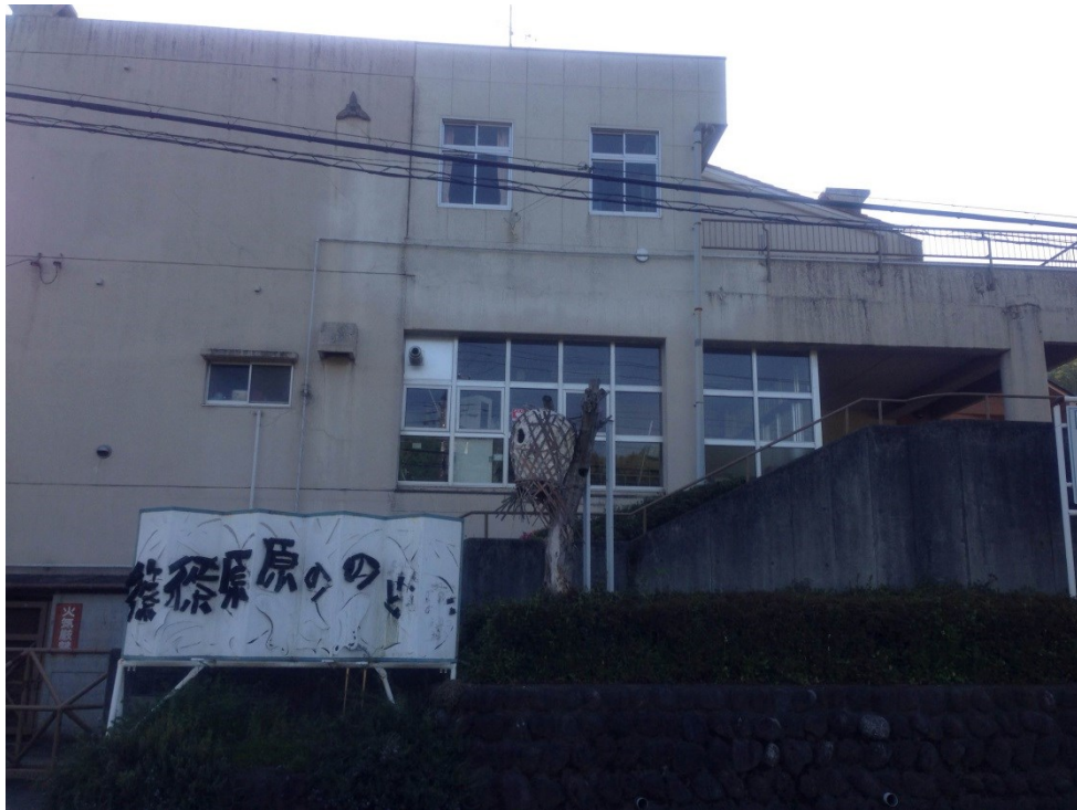
図 4-1: 篠原の里センター外観①
