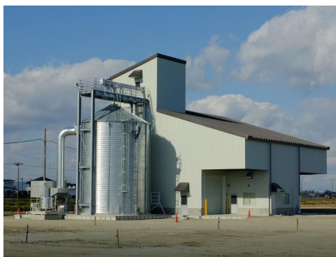
写真 3-1 国の復興支援によりあらたに建設されたライスセンター（寺島地区）
