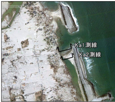
図-2.4.12 山元海岸笠野地区の測線位置
