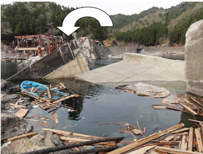
写真-2.5.7 岩手県両石漁港での重力式堤防の転倒 （撮影：2011年3月29日）
