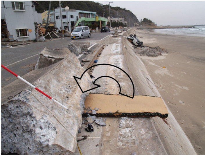
写真-2.5.6 波返工の破損（福島県豊間海岸） （撮影：2011年4月）
