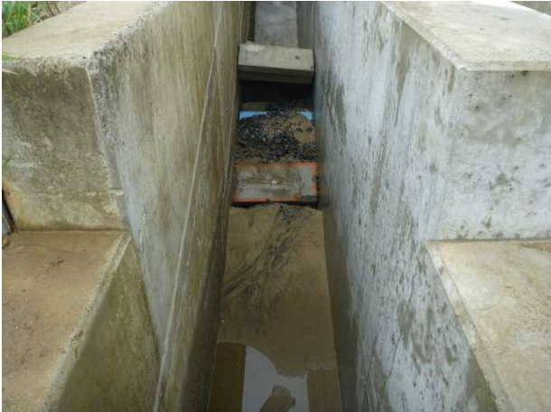
写真-2.6.14 越流後における裏法尻の状況 (地盤改良なし)
