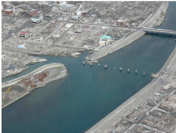
写真-2.4.7 大槌川右岸の破堤部（撮影：2011年5月）
