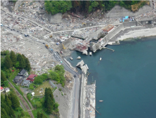
写真-2.4.5 両石漁港海岸の海岸堤防の被災 (撮影：2011 年 5 月)
