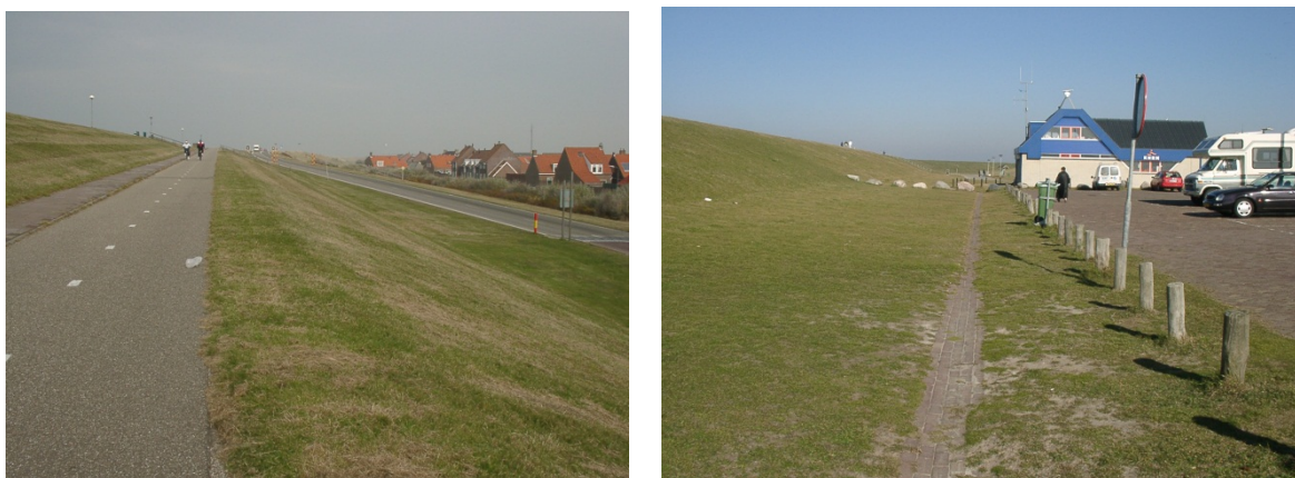
写真-2.3.1 裏法被覆工の例（左：Westkappelle Zeedijk，右：Strandslag Petten）
