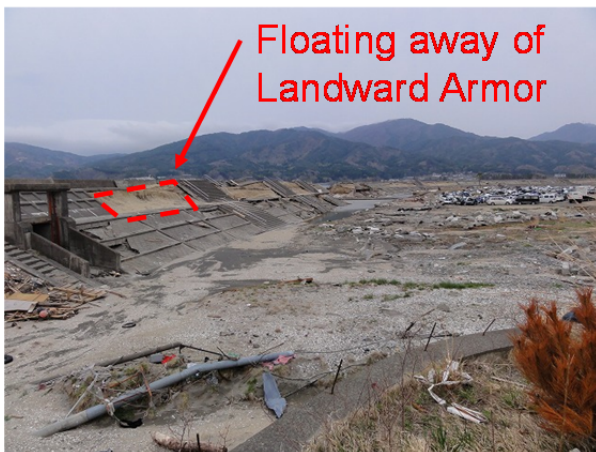
写真-2.5.4 裏法被覆工の流失(岩手県金浜海岸) (撮影:2011年5月)
