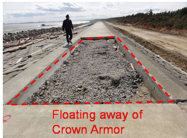
写真-2.5.5 天端被覆工の流失(宮城県大曲海岸) (撮影:2011年5月)
