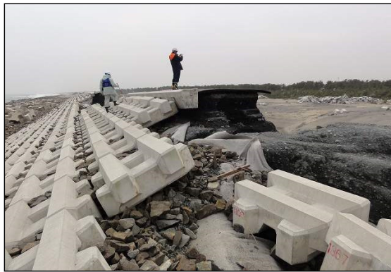
写真-2.4.1 天端とともに残った表法被覆工（奥）と天端とともに被災した表法被覆工（手前） （撮影：2011年3月20日）
