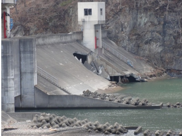
写真-2.5.8 表法先の洗掘からの被災(岩手県水海海岸) (撮影：2011年3月29日)
