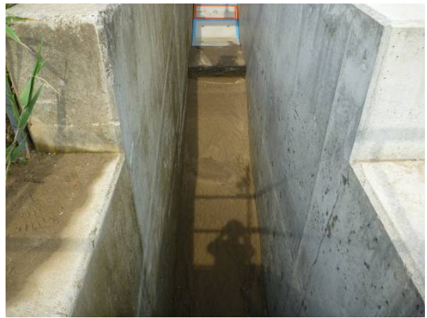
写真-2.6.15 越流後における裏法尻の状況 (地盤改良あり)
