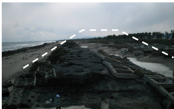
写真-2.5.3 天端・裏法が削られた海岸堤防 (撮影：2011年3月20日)
