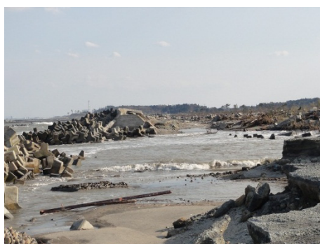
写真-2.4.2 直立堤の破堤部（山元海岸，撮影：2011年3月19日）
