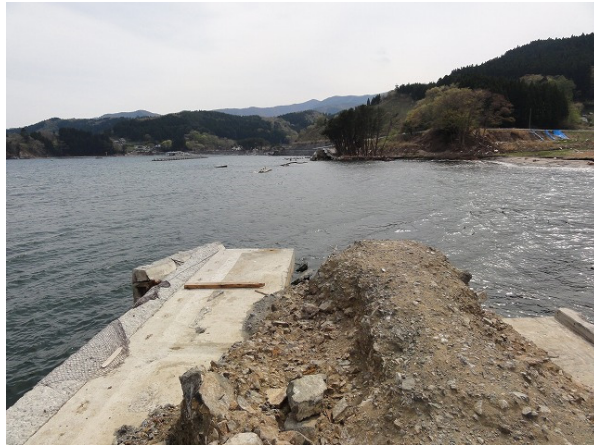
写真-2.4.4 越喜来海岸の破堤部（撮影：2011年3月29日）
