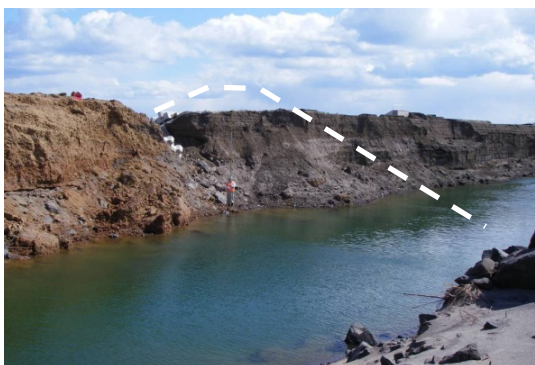
写真-2.5.2 海岸堤防陸側の深掘れ (撮影：2011年3月20日)
