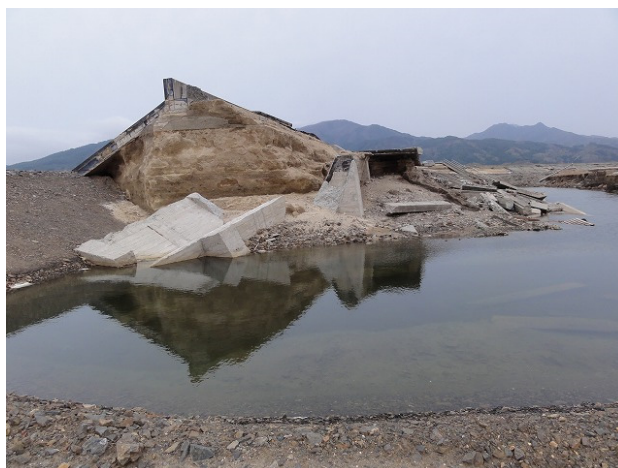
写真-2.4.6 金浜海岸の破堤部（撮影：2011年3月29日）
