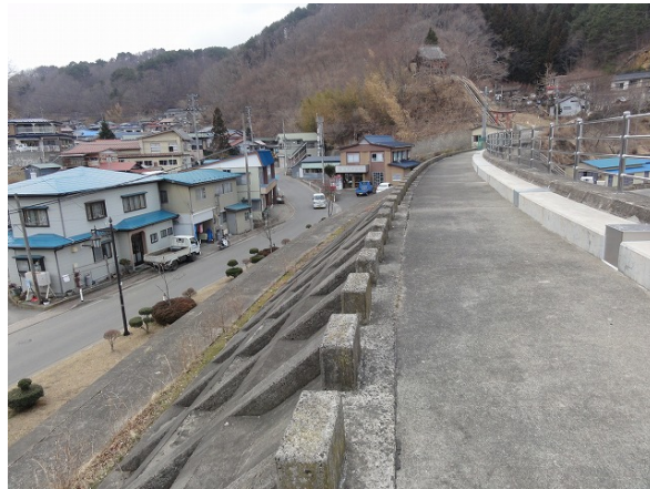
写真-2.5.1 海岸堤防によって浸水を免れた岩手県太田名部海岸（撮影：2011年3月30日）
