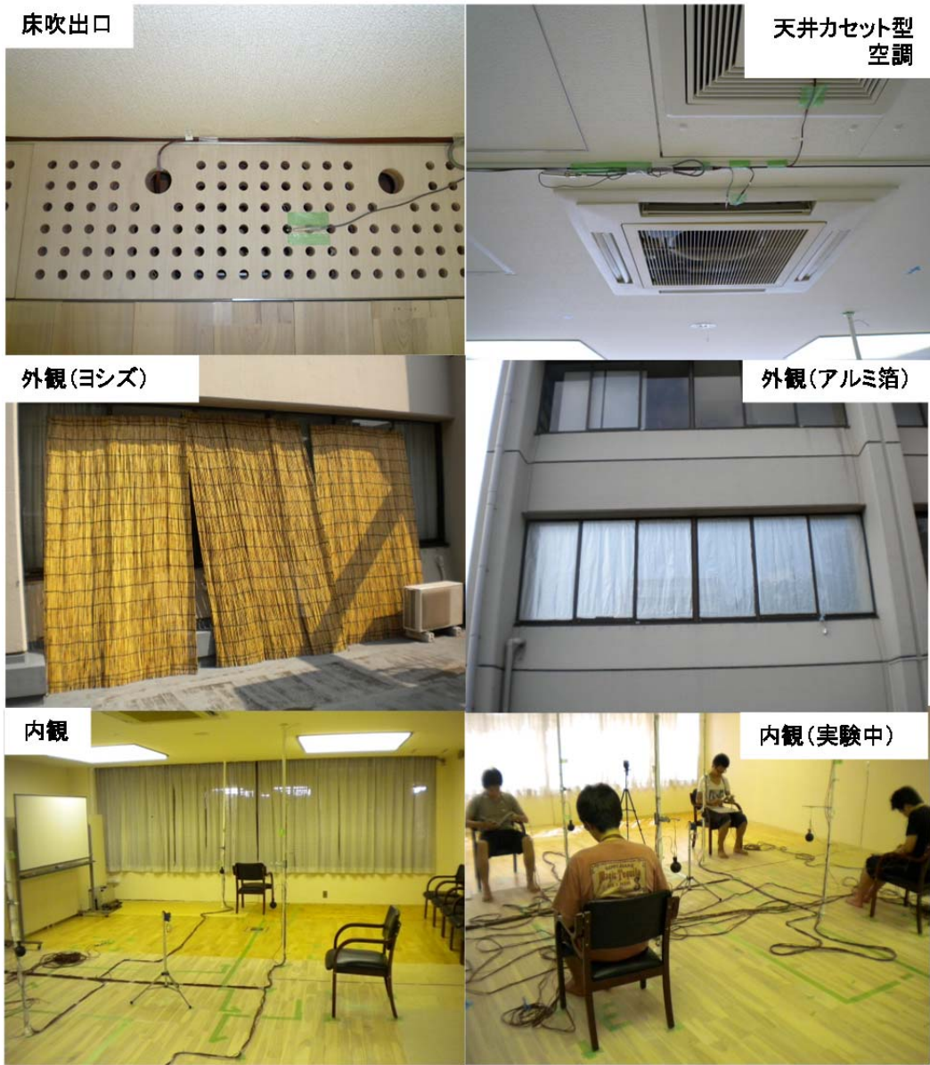
図 2-2 実居室の状況
