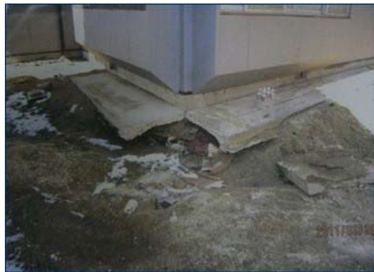
図-42 地盤がえぐられ浮いた状態の基礎（被災者提供写真）
