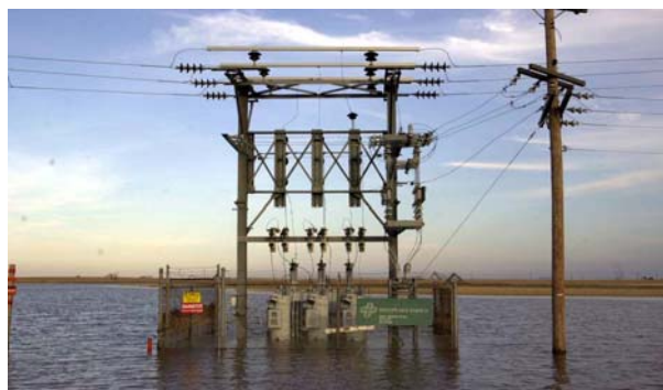
図-126 変電所の浸水
