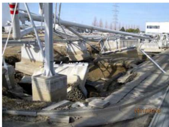
図-128 ガス供給施設の被害 139)
