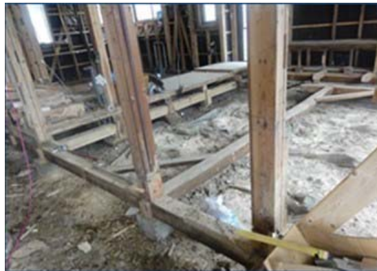
図-16 柱と土台を残しすべて撤去した床（被災者提供写真）
