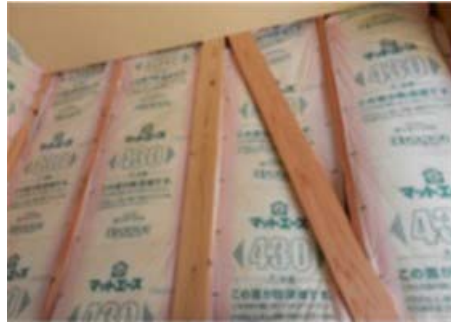
図-18 新築建物における内壁の断熱材の設置状況（新築住宅にて撮影）
