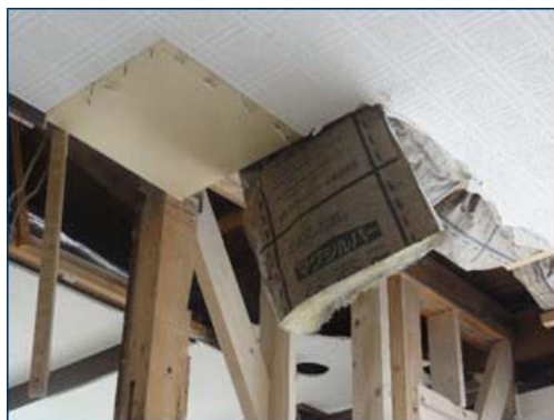
図-34 工事の際、天井断熱材も交換（訪問調査宅にて撮影）
