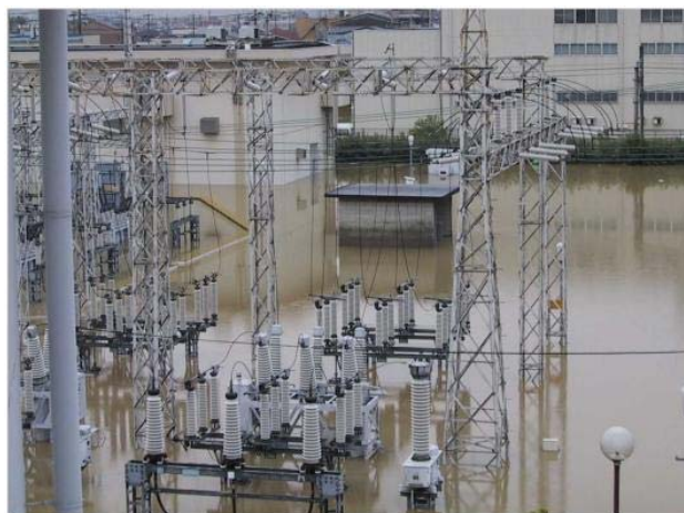
図-127 変電所の浸水（中部電力提供）
