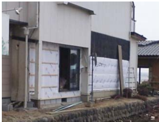
図-25 被災した部分の交換（防水シート貼り）（被災者提供写真）
