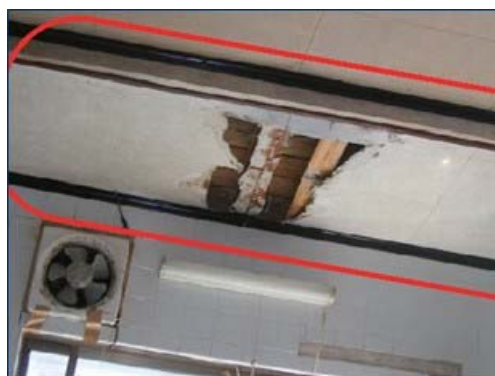
図-33 吸水・膨張している石膏ボード 29)
