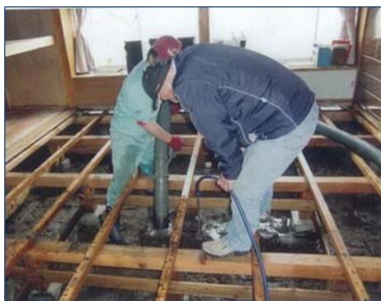
図-3 バキューム吸引による床下土砂の撤去（被災者提供写真）
