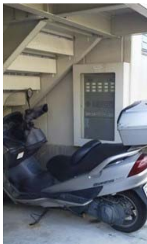
図-121 地盤から 1m 程度に設置されている主配線盤
