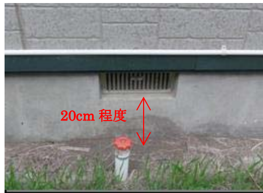
図-12 一般的な床下換気孔の例（訪問調査宅にて撮影）
