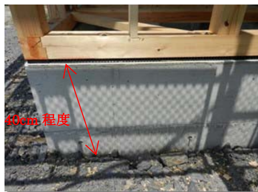
図-13 基礎パッキン工法（ネコ土台）による床下換気工法の例（新築住宅を撮影）
