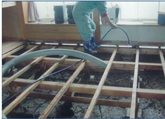
図-15 床下土砂の撤去・洗浄（被災者提供写真）
