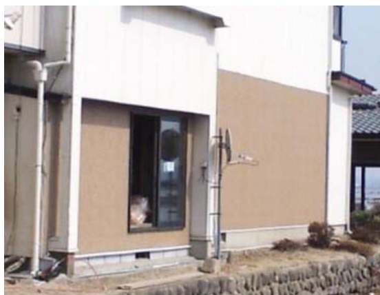
図-26 被災した部分の交換（サイディング）（被災者提供写真）
