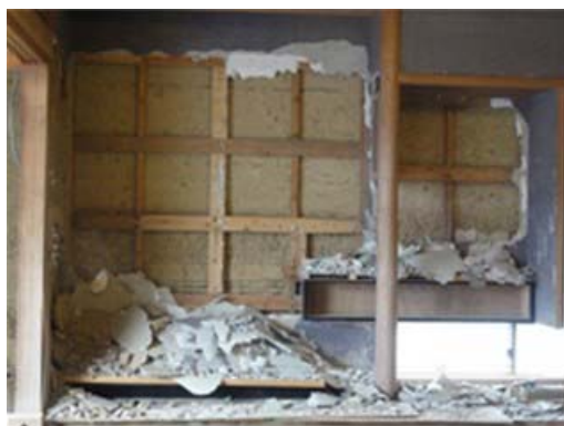
図-20 石膏ボードの撤去状況（訪問調査宅にて撮影）
