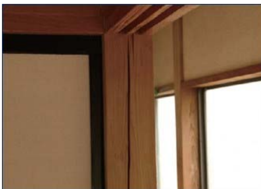
図-48 亀裂が入っている柱 29)
