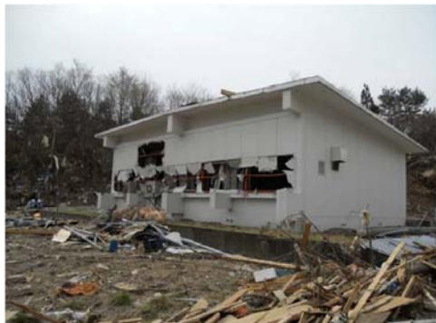
図-129 通信基地局の被害
