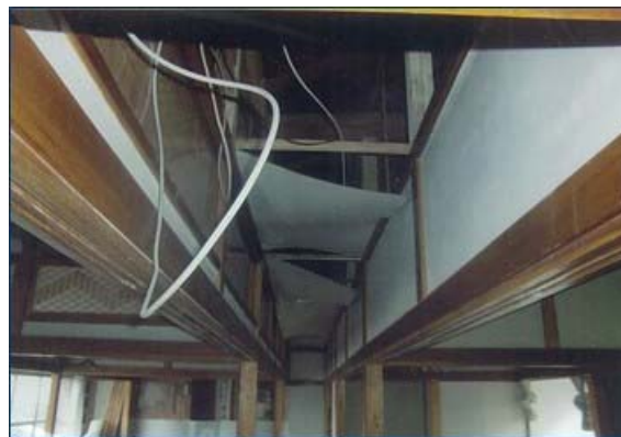
図-38 天井工事と併せて，配線工事をしている事例（被災者提供写真）
