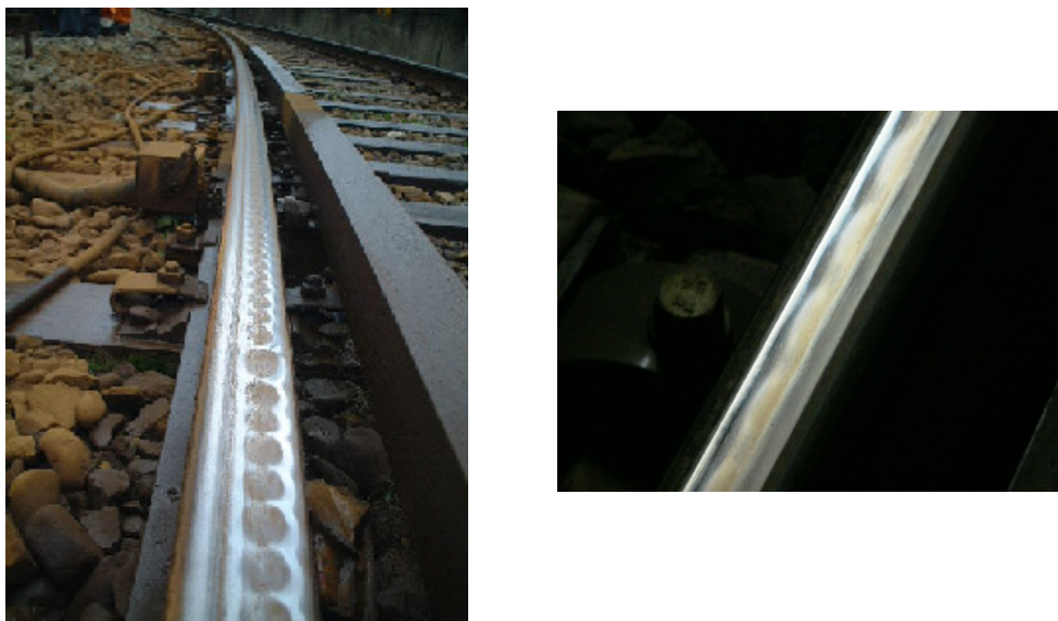
図2-6 急曲線の内軌側レールに発生した波状摩耗
