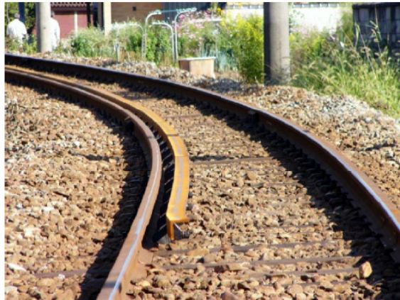
図2-7 脱線防止ガードの取り付け例 S1-2)
