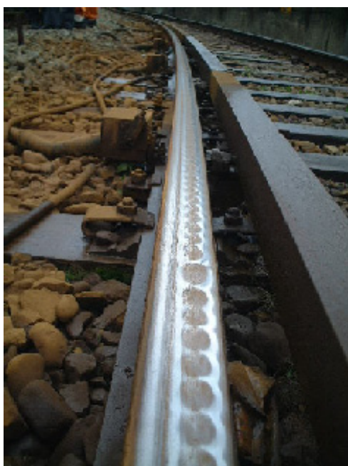
図4-4 波状摩耗の発生例Ⅲ（民鉄軌道線、100mR, 内軌）
