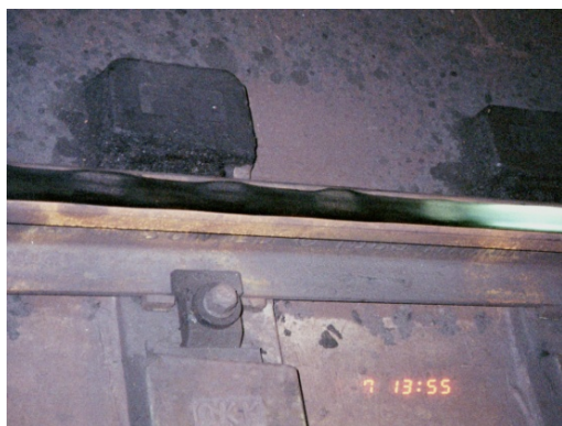
(a)直結道床, 201mR, \lambda=110\text{-}150\text{mm} V=55\text{km/h} , f=100\text{-}140\text{Hz}
