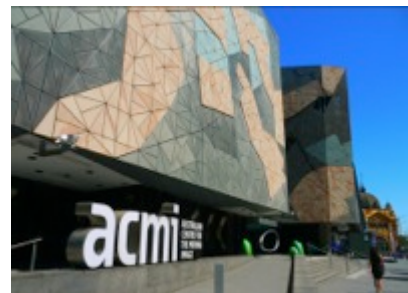
図 28. ACMI の外観 (2012.2.23) (撮影 小川明子)
