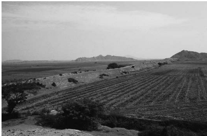
写真4-5 アスコペの水路。ペルー北部の海岸地帯にあり、日干しレンガを積み上げた堤道の上に灌漑水路が走っている
