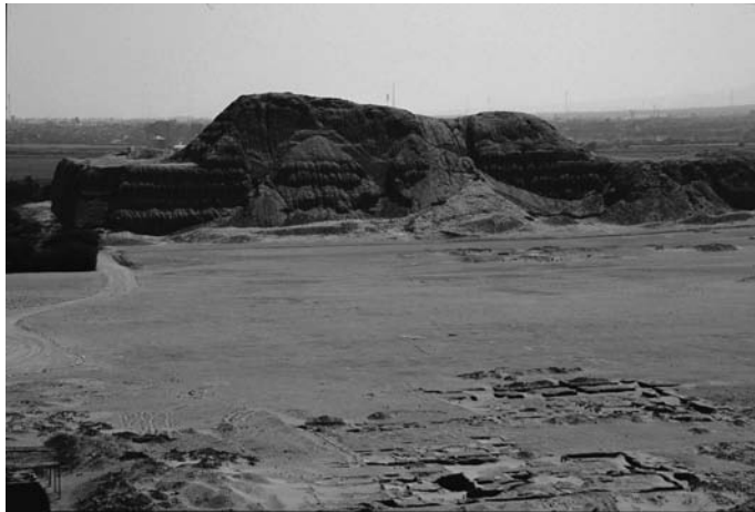
写真4-4 モチェの「太陽神殿（ワカ・デル・ソル）」。日干しレンガを積み上げて造られている
