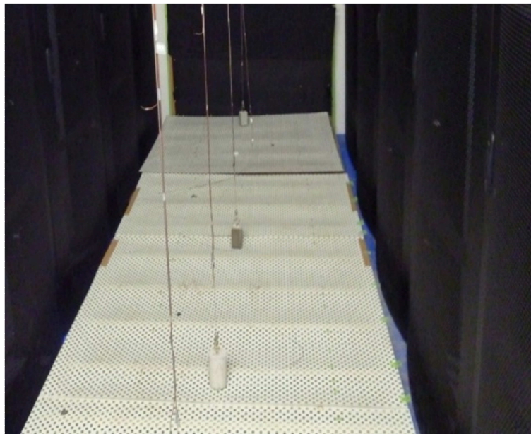
写真 6 - 2 床吹出し方式給気口
