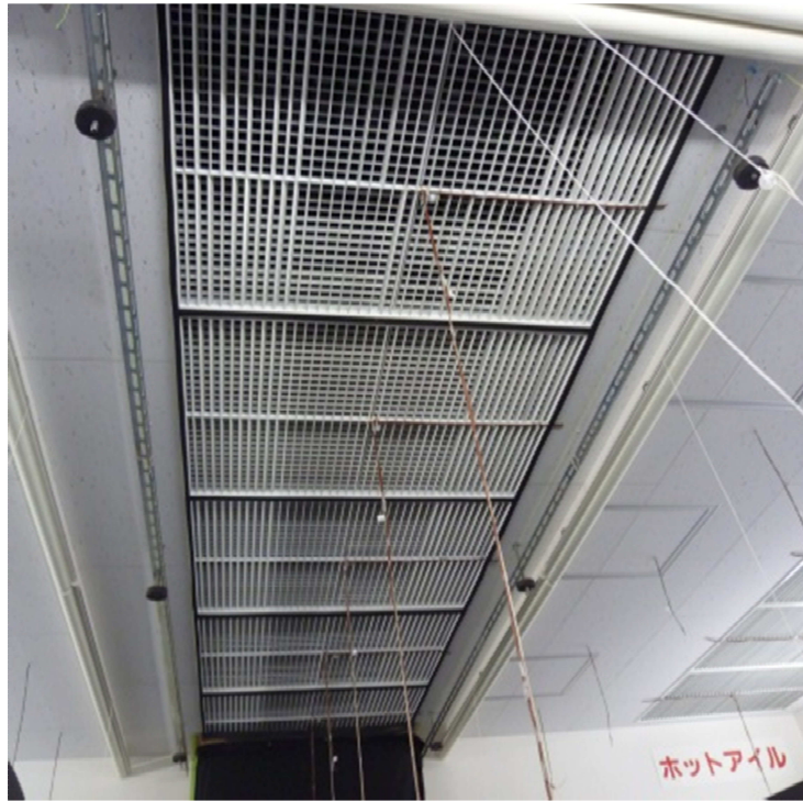
写真 6 - 1 天井吹出し方式給気口
