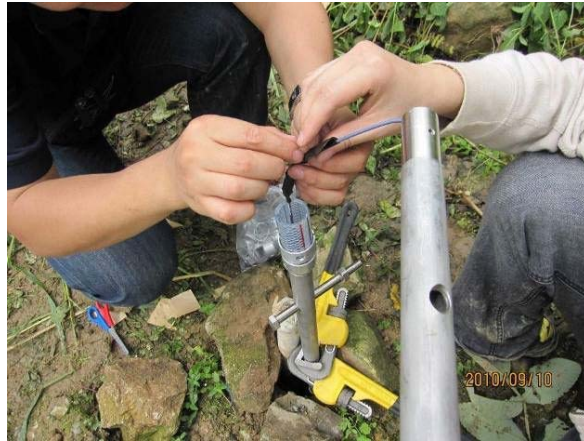
写真4 - 5 センサーユニットのケーブルの接続
