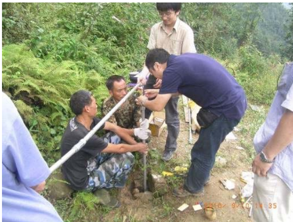
写真4 - 6 小型孔内傾斜計の設置状況
