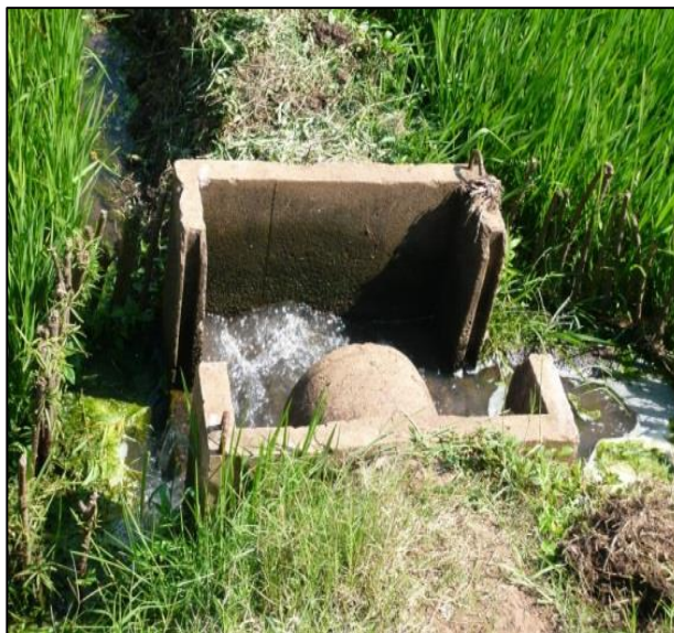
図 4.3 プロットの取水口 (2012 年撮影)
