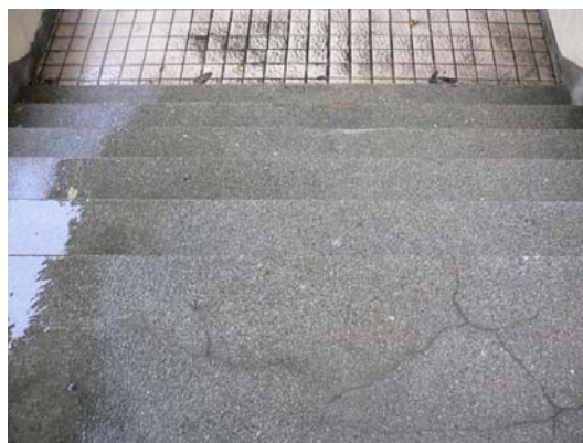
【図 1-102】床の平面の人造石洗出し (筆者撮影)
