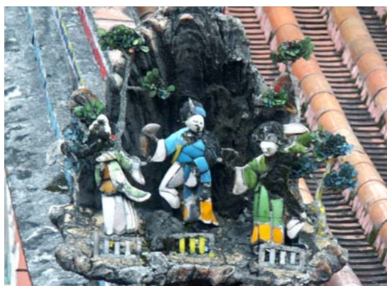
【図 1-14】排頭の設置場所は屋根から突き出た平台の位置（筆者撮影）
