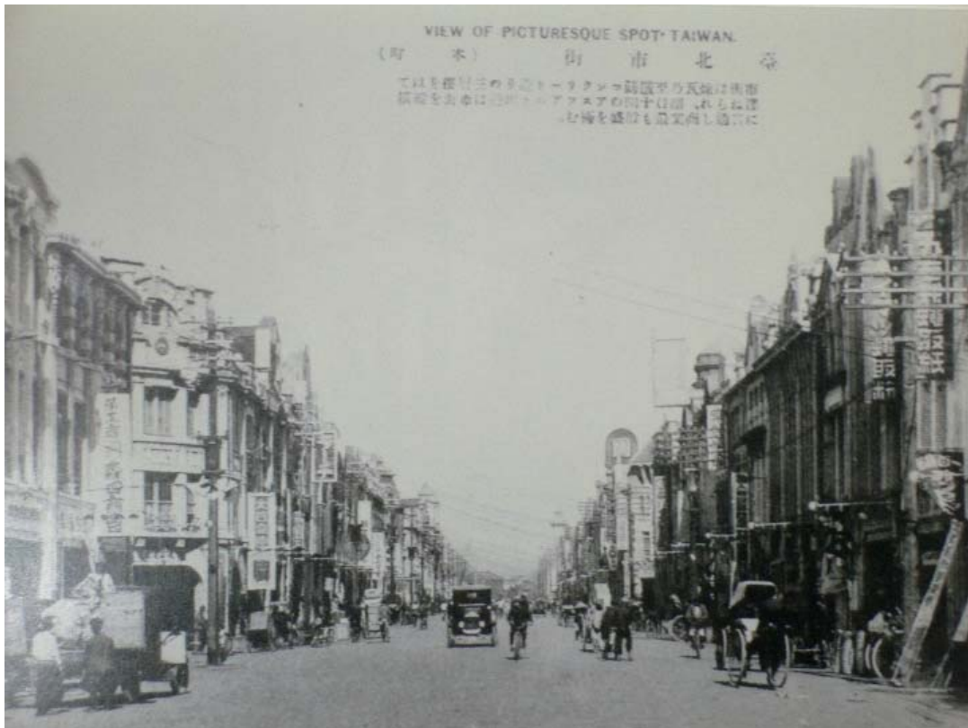
【図 1-110】台北本町街並みの改築（引用旧絵葉書、中原大學近代建築研究室蔵）
