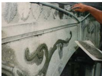
【図 1-56】台湾土糊兼剪粘職人の使用する鏝（筆者撮影）
