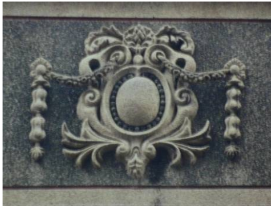
【図 1-105】型製造の人造石洗出し（筆者撮影）
