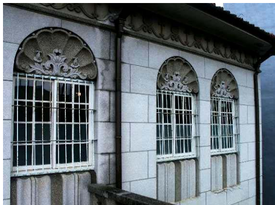
【図 1-97】外壁部の人造石 (筆者撮影)
