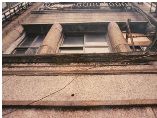
【図 1-101】外壁部の平面の人造石洗出し (筆者撮影)
