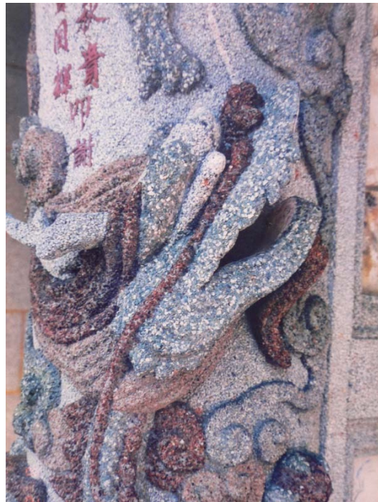
【図2-20】土糊の人造石洗出しの完成（筆者撮影）
