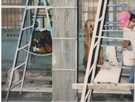
【図2-3】木製の目地棒をセメントペーストやモルタルで固定する（筆者撮影）
