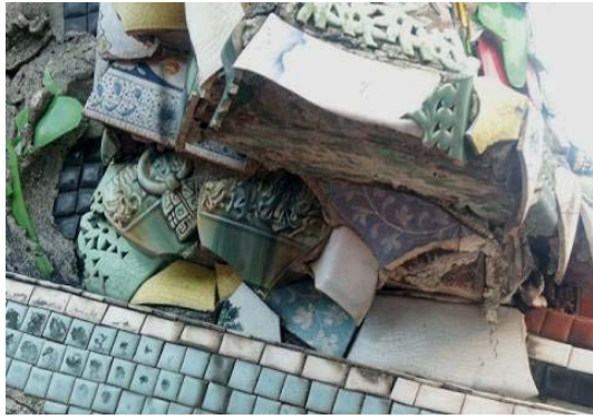
【図 2-46】陶瓷器・茶碗・皿・瓶・甕などの破片はすべて剪粘の貼付材料（筆者撮影）
