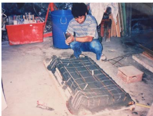
【図2-27】骨組みの組立作業（郭互富提供）
