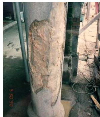
【図 2-38】塗下地の不良による落下（筆者撮影）
