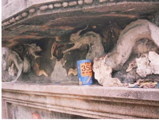
【図2-15】下地の清掃と処理（筆者撮影）
