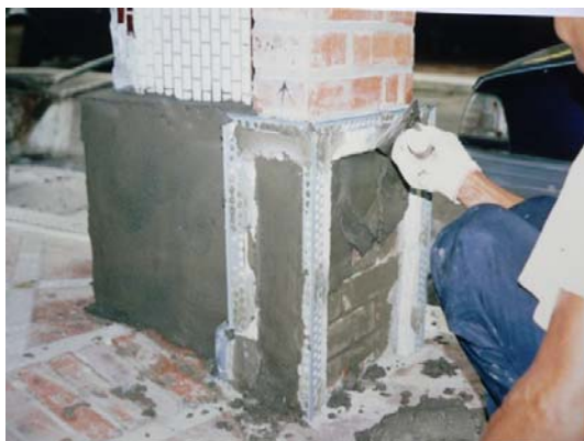
【図2-5】種石を練り合わせたモルタルを上塗り（筆者撮影）
