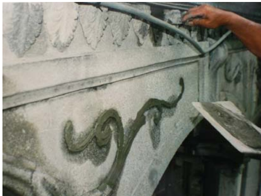
【図2-17】灰泥を塗り付け（筆者撮影）
