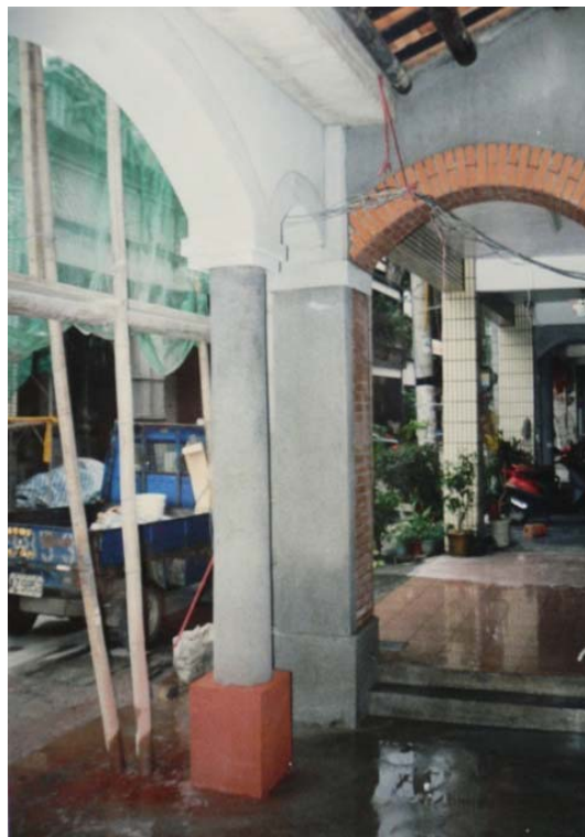
【図2-8】種石を表面に露出させ（筆者撮影）
