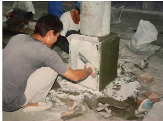
【図2-14】表面に新聞紙を貼り付け、石粉を塗り（筆者撮影）
