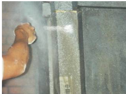
【図2-9】上塗り後、表面が硬化し始めた頃（筆者撮影） 【図2-10】噴霧器を使って洗い出し（筆者撮影）
