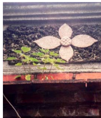
【図 2-39】植物による損傷（筆者撮影）
