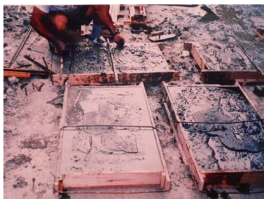
【図2-28】モルタルを型に入れる作業（郭互富提供）
