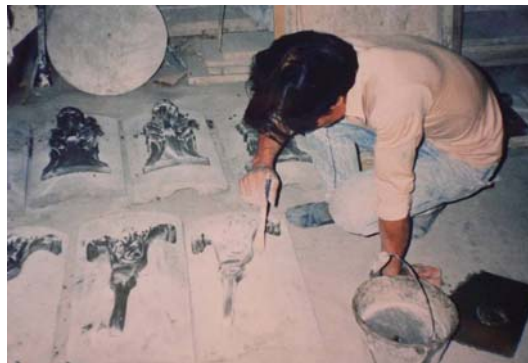
【図 2-30】型とモルタルの間の剥離剤には鉛パウダーを塗りつけ（郭互富提供）
