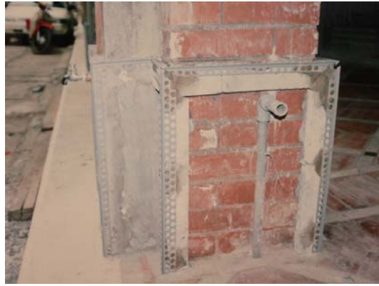
【図2-4】下地の清掃と処理（筆者撮影）
