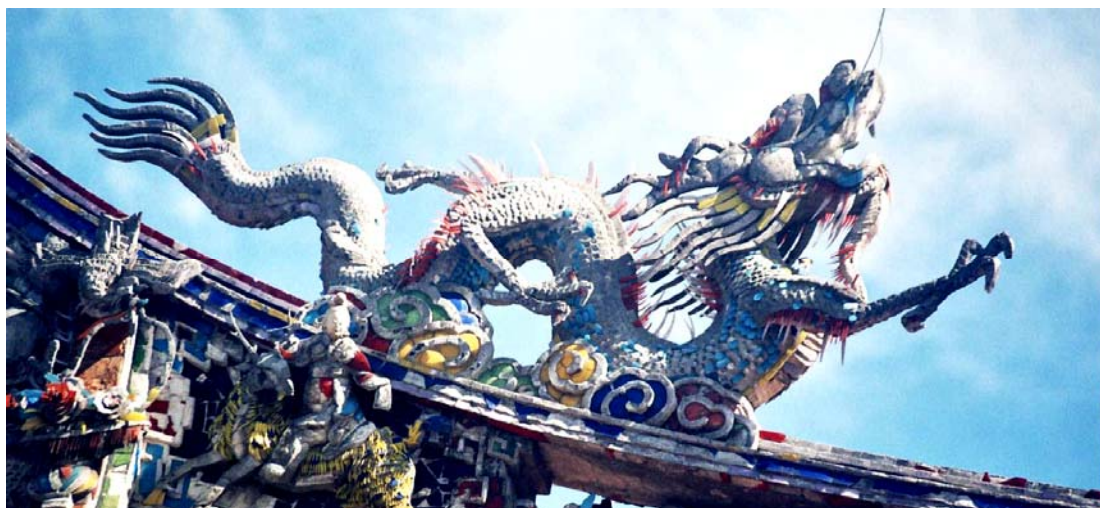
【図 2-60】1953年台北竜山寺の修復工事でガラス片の剪粘作品（筆者撮影）
