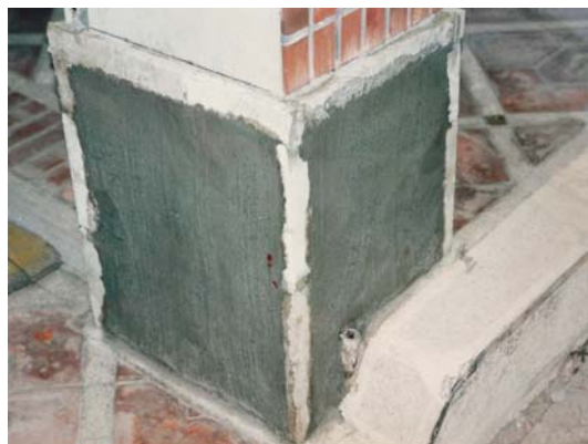
【図2-6】種石を練り合わせたモルタルを上塗りした（筆者撮影）
