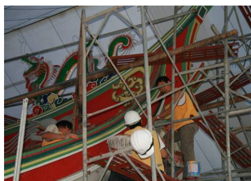
【図 4-27】建築物の屋根の上、剪粘職人の工事現場（筆者撮影）
