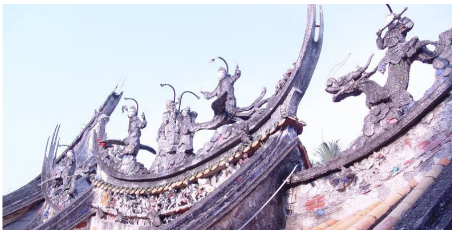
【図 4-34】屋根上の剪粘は時間と共に劣化して原型を失い、元通りに修復するのは非常に困難である。（雲林麥寮拱範宮、筆者撮影）
