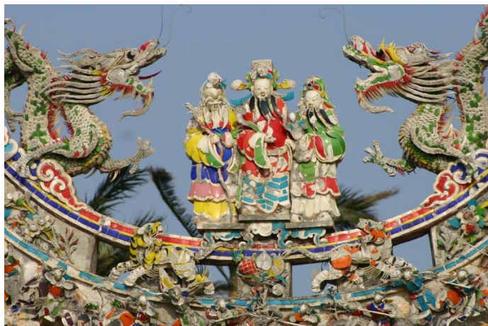
【図 4-33】屋根上の剪粘作品、碗片やガラスなどの表面材質が剥がれやすい（観音保生大帝廟、筆者撮影）
