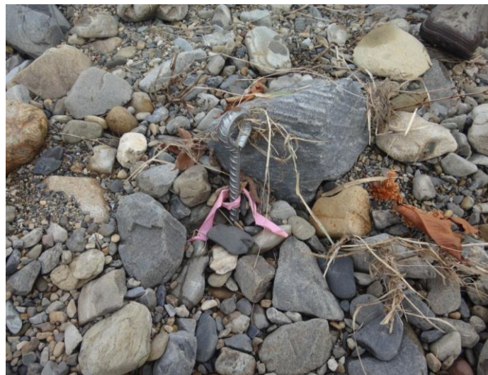
図 5-14 洪水後の杭 2 と付近の大礫
