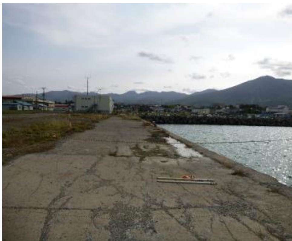
Fig.3-4 路面沈下部
