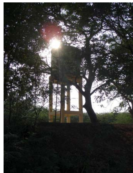
SHG(自治会)メンバーがお金を集めて作った Head Water Tank(貯水槽)。メンバーではない村人は利用できないことから争いに発展。現在は誰も利用しない。
