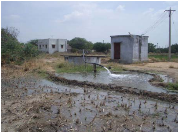
99年に完成した公共灌漑用井戸は、80m地下に埋めたディーゼルモーターつきポンプにより深層の被圧地下水を汲み上げている。費用返済として魚池プロジェクトがある。
