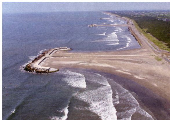
写真 4.1.1.1.5 HL5号(北側から南を望む)
