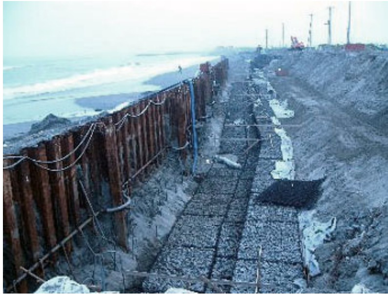
写真 3.1.10 南九十九里浜で行われているフトンカゴ式護岸工事現場(2005年6月撮影)
