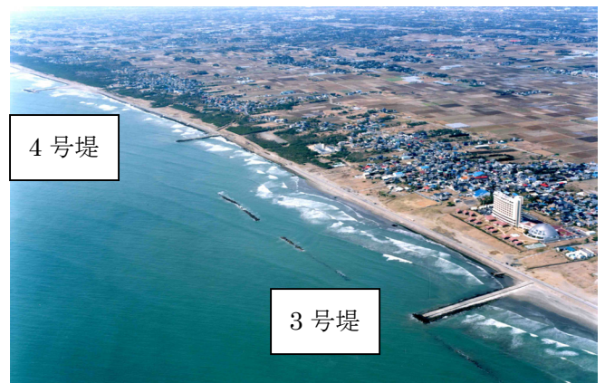
写真 4.1.1.1.4 HL 4号(北側から南を望む)
