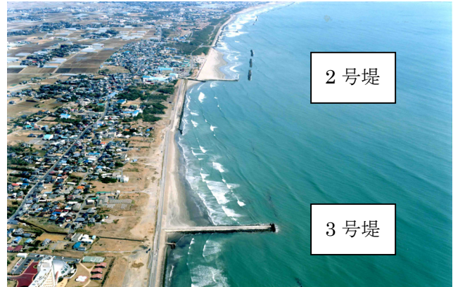
写真 4.1.1.1.3 HL 3号(南側から北を望む)
