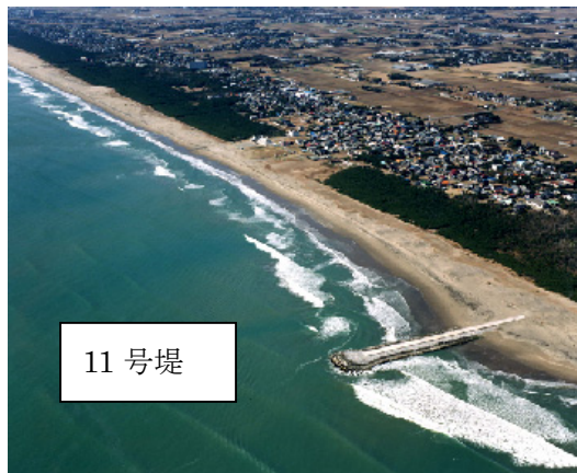
写真 4.1.1.1.11 HL11(北側から南側を望む)
