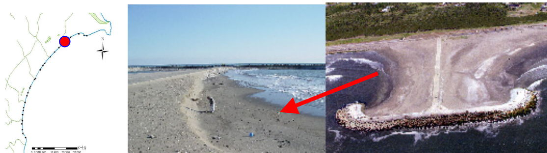
図-3.1.5 5号ヘッドランドの西側は冬季に侵食される
