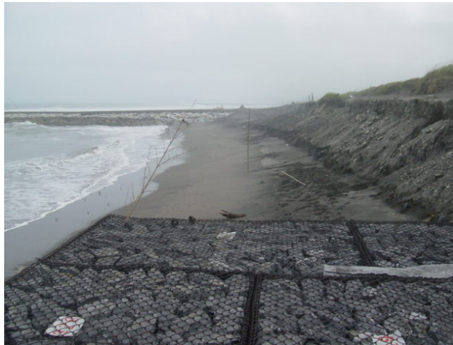
写真 4.1.1.2.3 川は一宮川。右は、ハマガケ防止のための工事風景。
