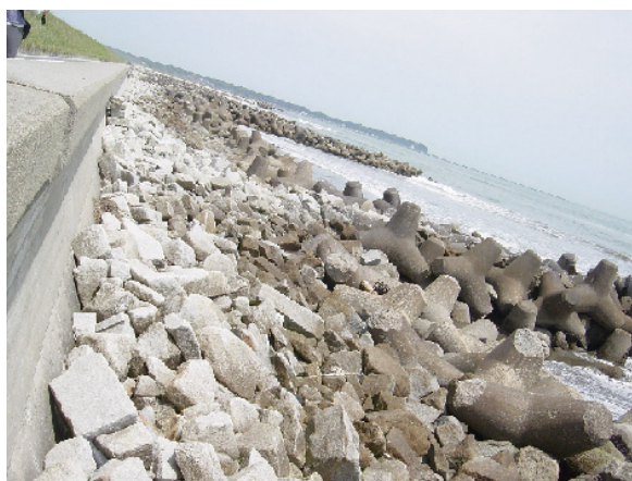
図-3.1.4 消波ブロックと直立護岸の野中海岸(2005年8月)
