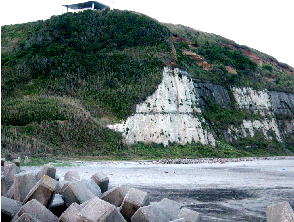
写真-2.1.1 屏風ヶ浦の海食崖（2004年9月14日撮影）
