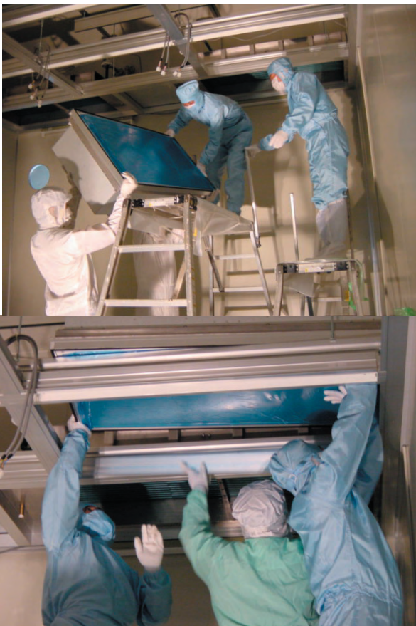
図3.1.2.6 FFU施工の様子
