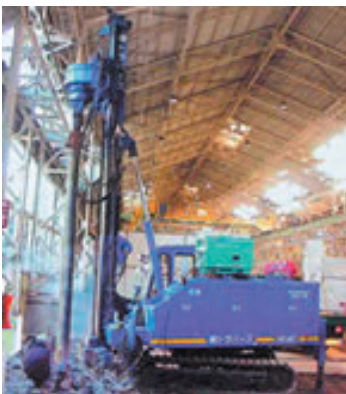
写真 3.1.1.6 工場屋内施工
