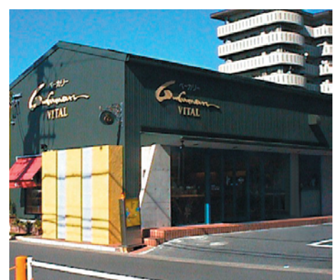
図 3.1.2.16 カバー構法事例 写真
