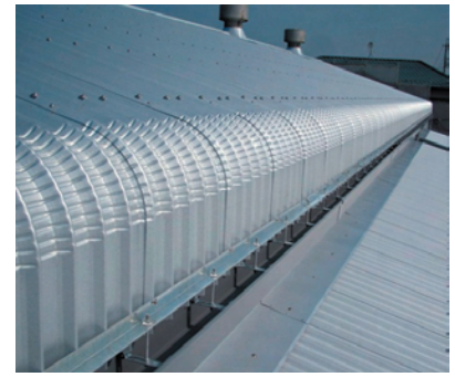
図 3.1.2.11 端部施工例写真
