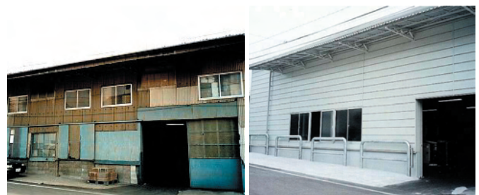
図 3.1.2.15 カバー構法壁面 写真
