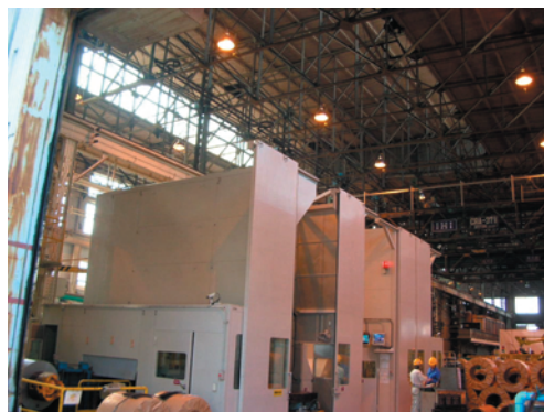
写真 3.1.1.7 工場屋内施工
