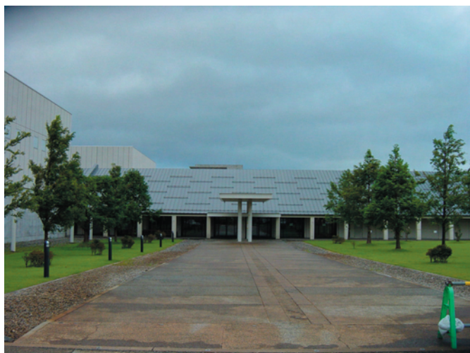
写真 A 2：南側立面
