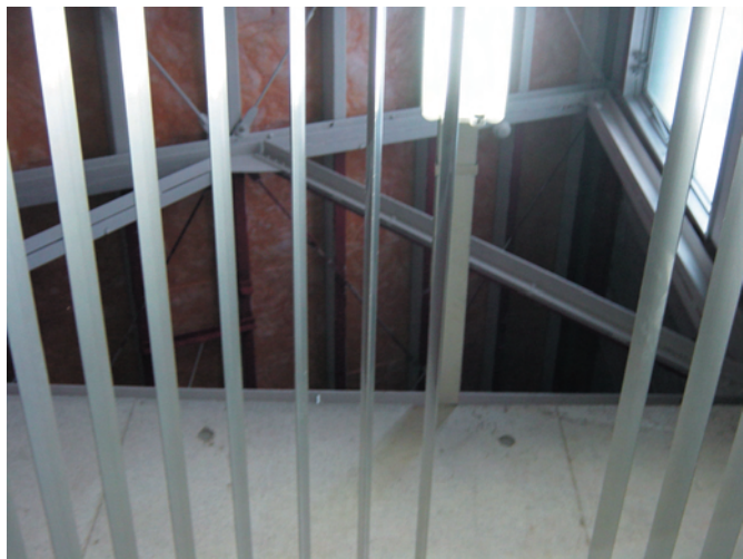
写真 A 6 : 廊下見上げ
