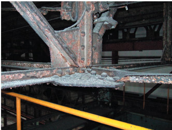
写真B 13：倉庫小屋組み現状
