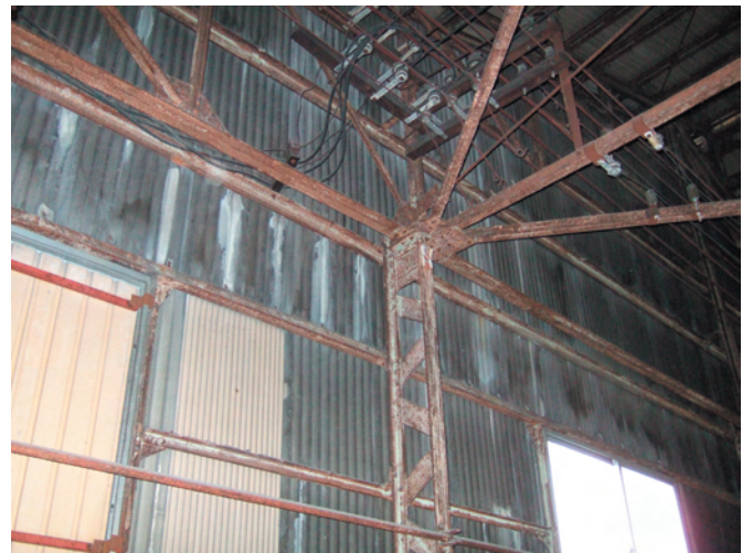
写真B 14：倉庫柱小屋組み現状
