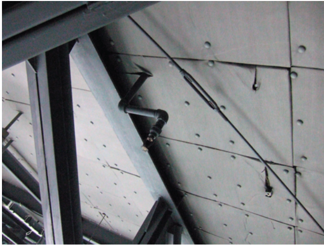
写真B 11：スプリンクラーと防音
