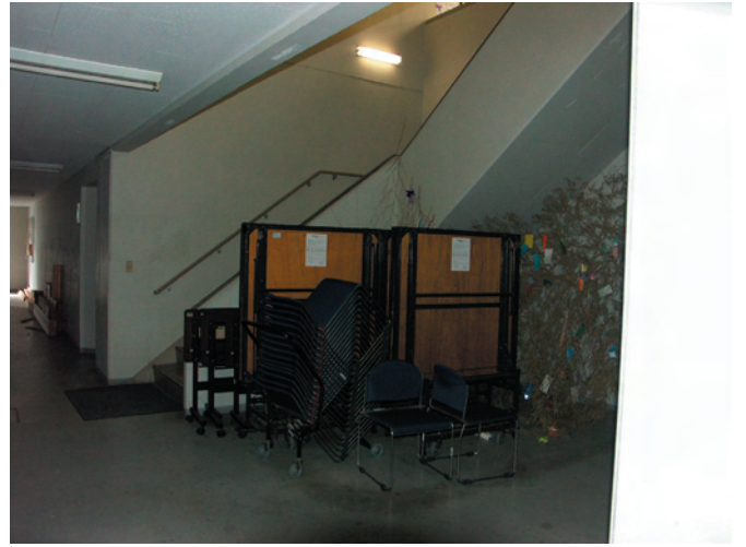
写真 D8：階段部
