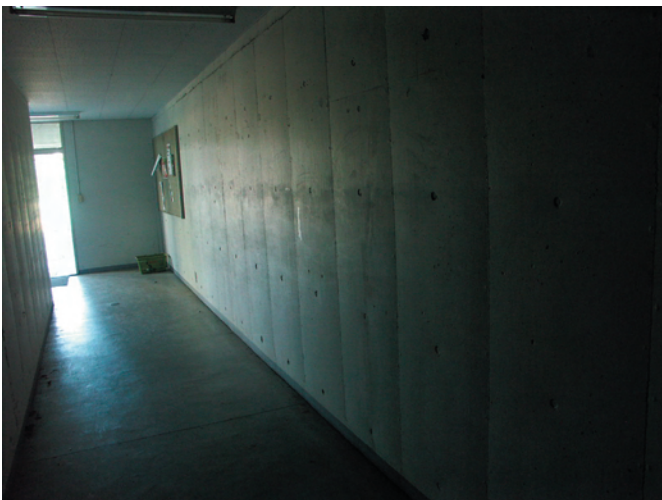
写真 D5：廊下
