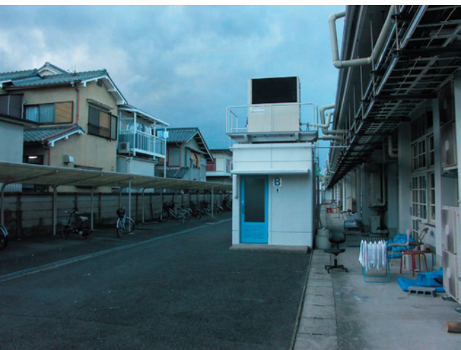
写真 D16：隣地との間隔
