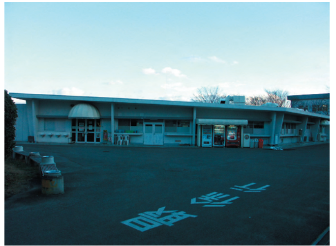
写真 D16：食堂棟
