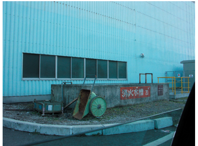
写真 C12：古い防火水槽
