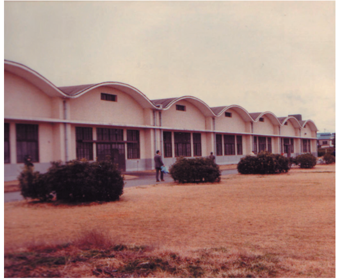
写真 D24：解体前外観
