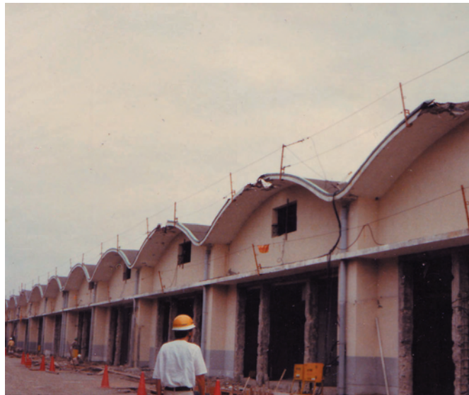
写真 D18：立面解体
