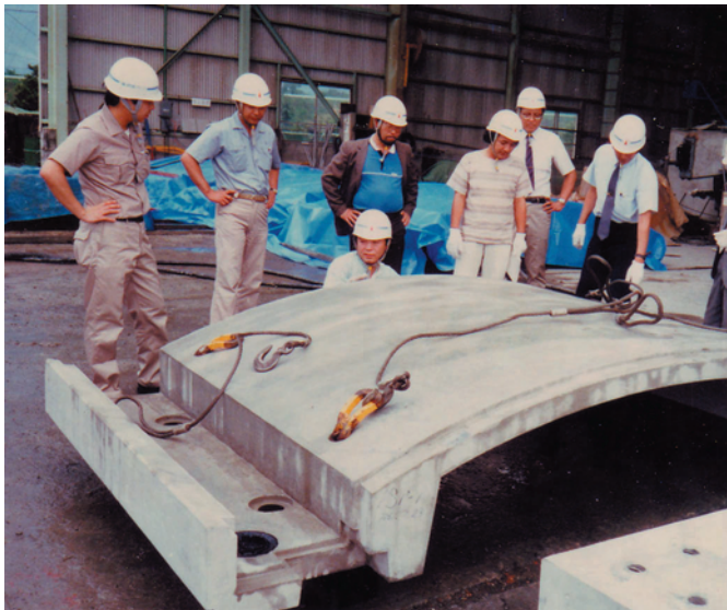
写真・図 D17：回廊部 PC 屋根
