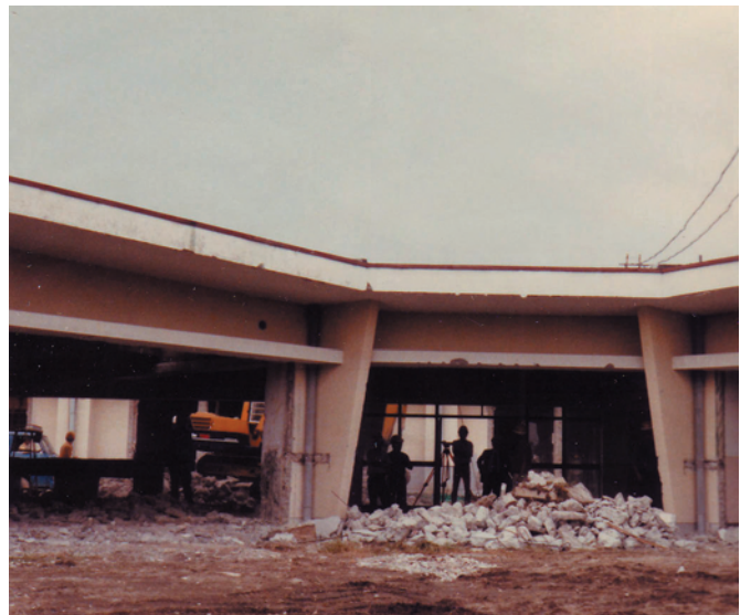
写真 D26：食堂棟解体
