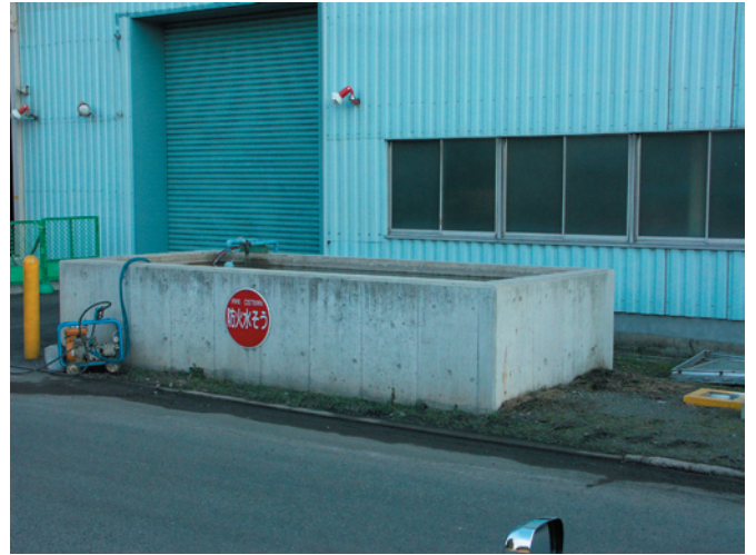
写真 C10：新しい防火水槽
