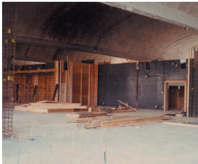
写真 D20：内部型枠
