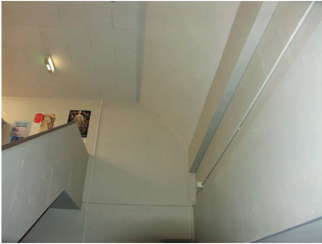
写真 D7：階段部見上げ
