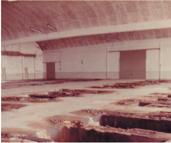
写真 D23：設備撤去後ピットの様子
