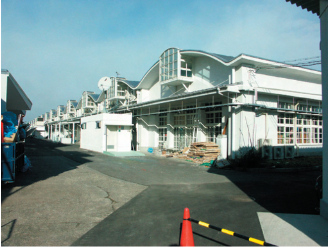
写真 D1：外壁
