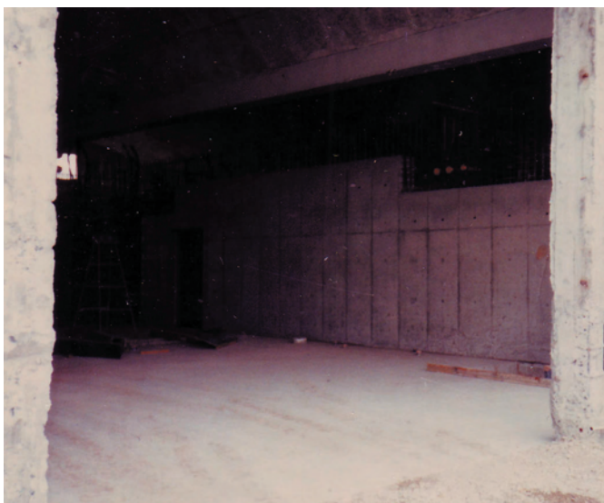
写真 D21：内部 PC 間仕切り打設
