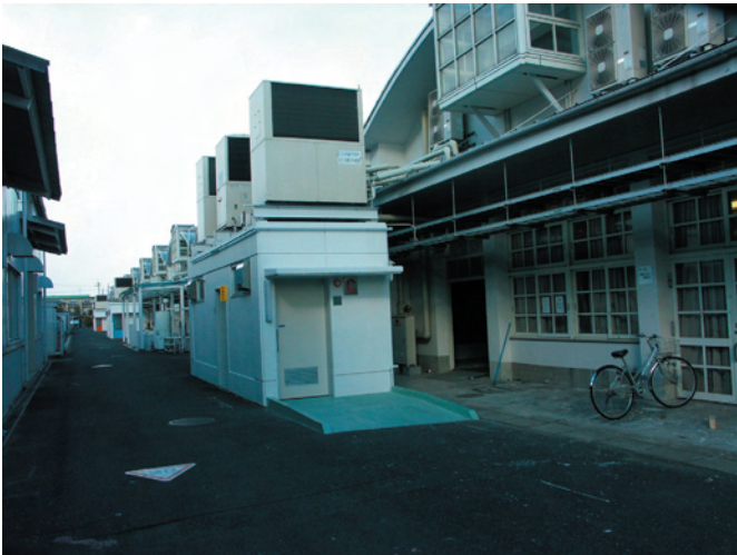
写真 D3：トイレ
