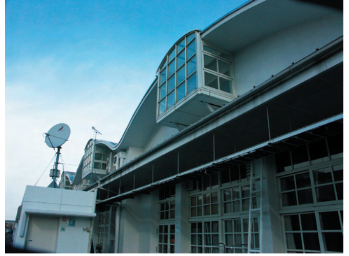
写真 D2：外壁
