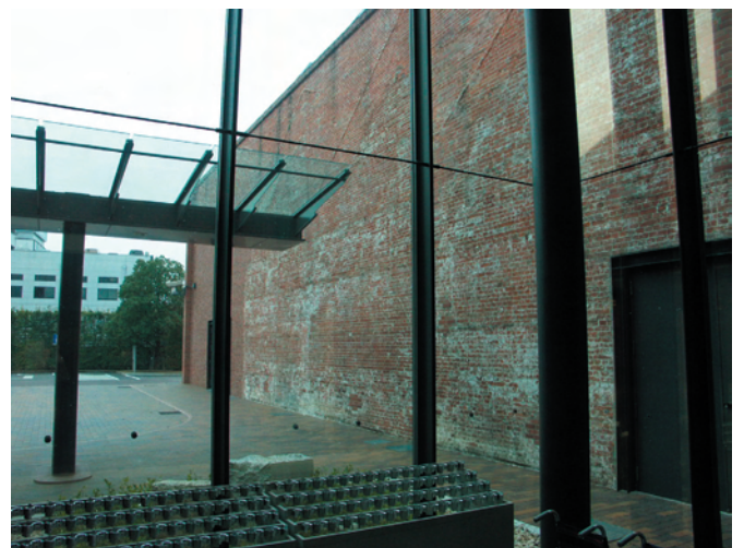
写真 E18：正面入口
