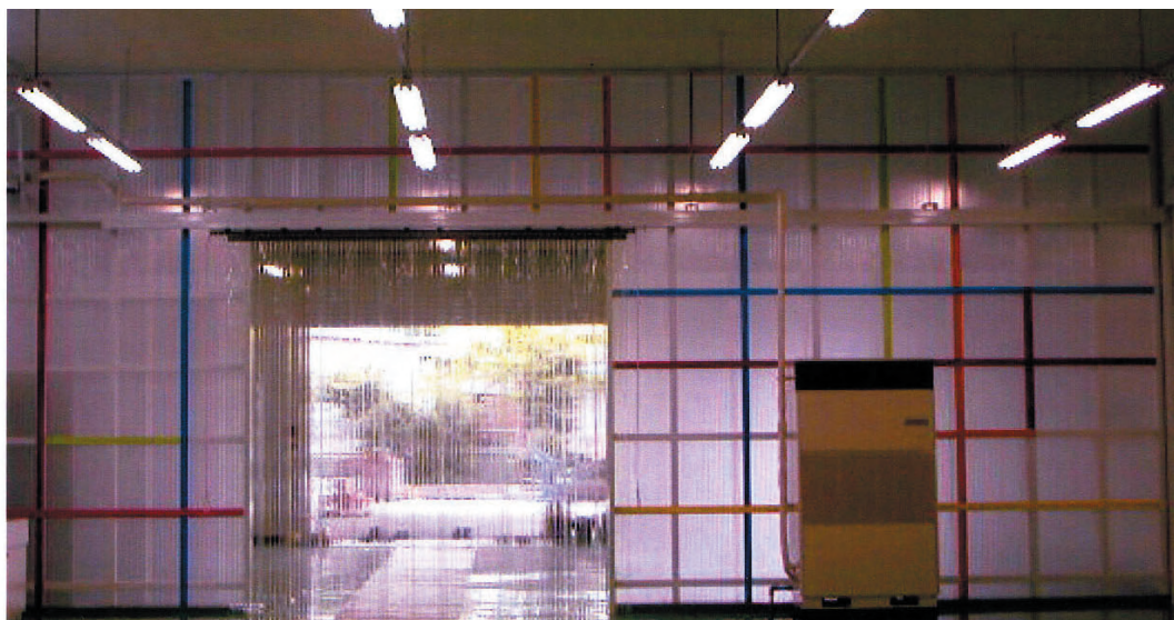
写真 F11：間仕切り
