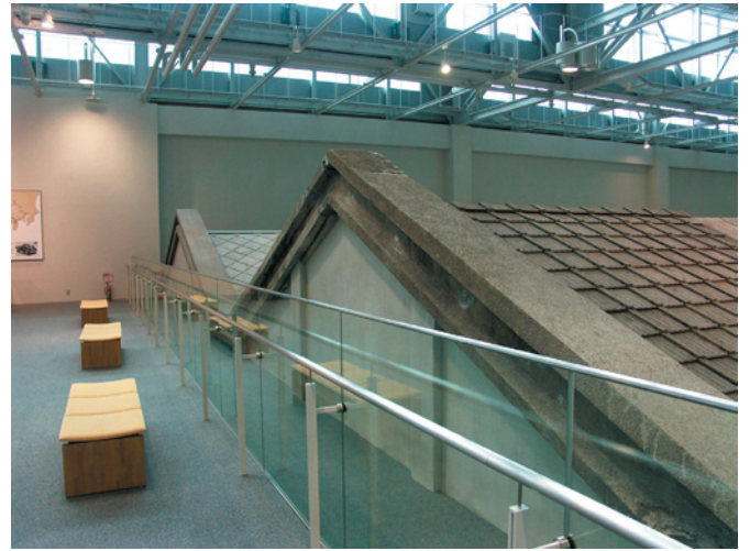
写真 E10：移築棟屋根
