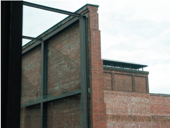
写真 E19：外部壁と補強
