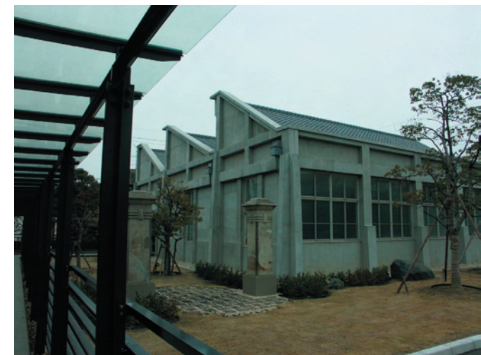
写真 E12：移築棟外観
