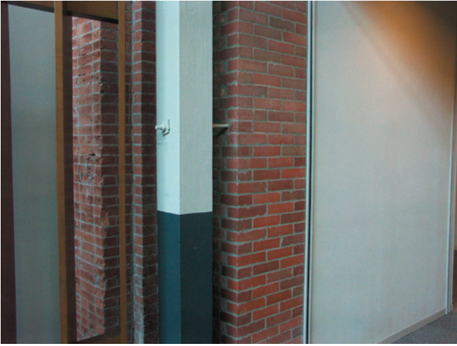
写真 E 1 : 繊維機械館壁と柱
