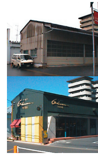
図4 カバー構法施工例
