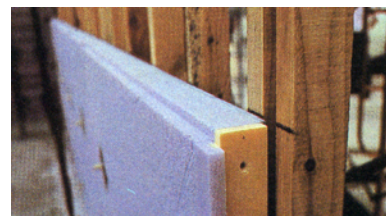
図 3.11 断熱材施工の様子
