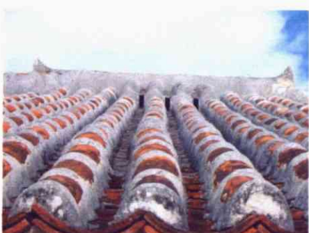
#79 漆喰を重ねて作る、 瓦屋根の通気孔
