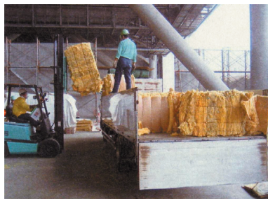
（解体工事全容 / 圧縮したグラスウールの積み込み / 再資源化工程への投入）
